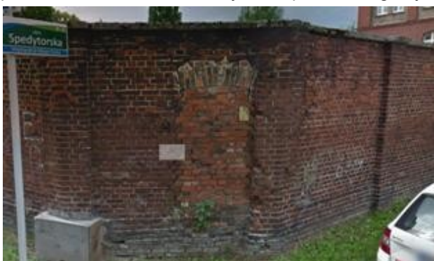
Część narożna ogrodzenia (przed przebudową).
