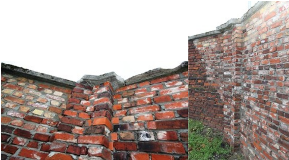
Fragmenty murów na różnych odcinkach zostały na przestrzeni lat uzupełnione ceglami i zaprawą różniącą się znacznie parametrami technicznymi i estetycznymi.
