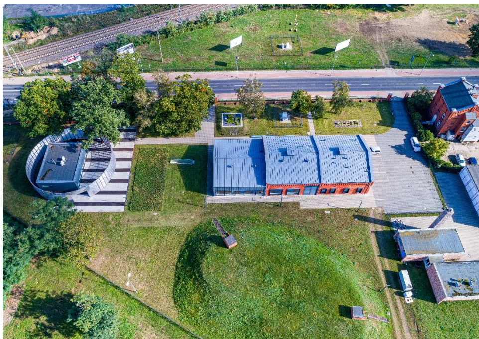
Rys. 1. Stacja Uzdatniania Wody w Zaborowie (wodociąg publiczny Leszno)
