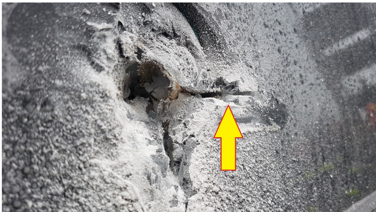
Rys. 463. Niewielkie przecięcie uzyskane przy pomocy piły szablstej
