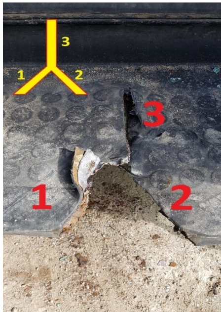
Rys. 411. Nacięcie w podłodze w literę Y
