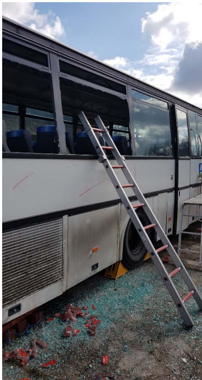
Rys. 399. Przestrzeń uzyskana po usunięciu okna
