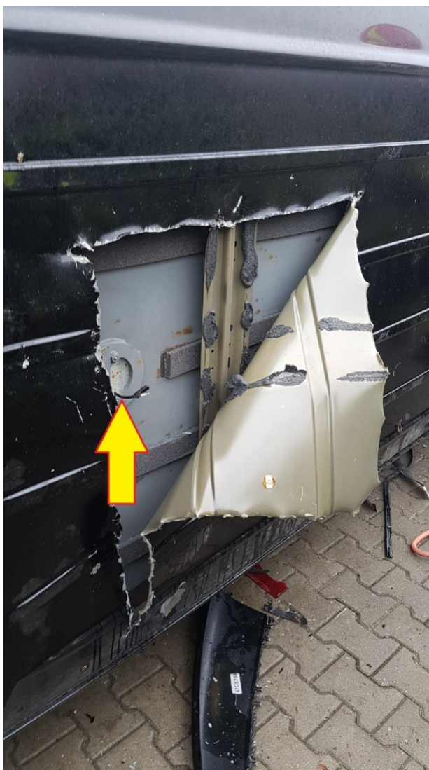
Rys. 455. Stalowe wzmocnienie dachu pod blaszanym poszyciem
