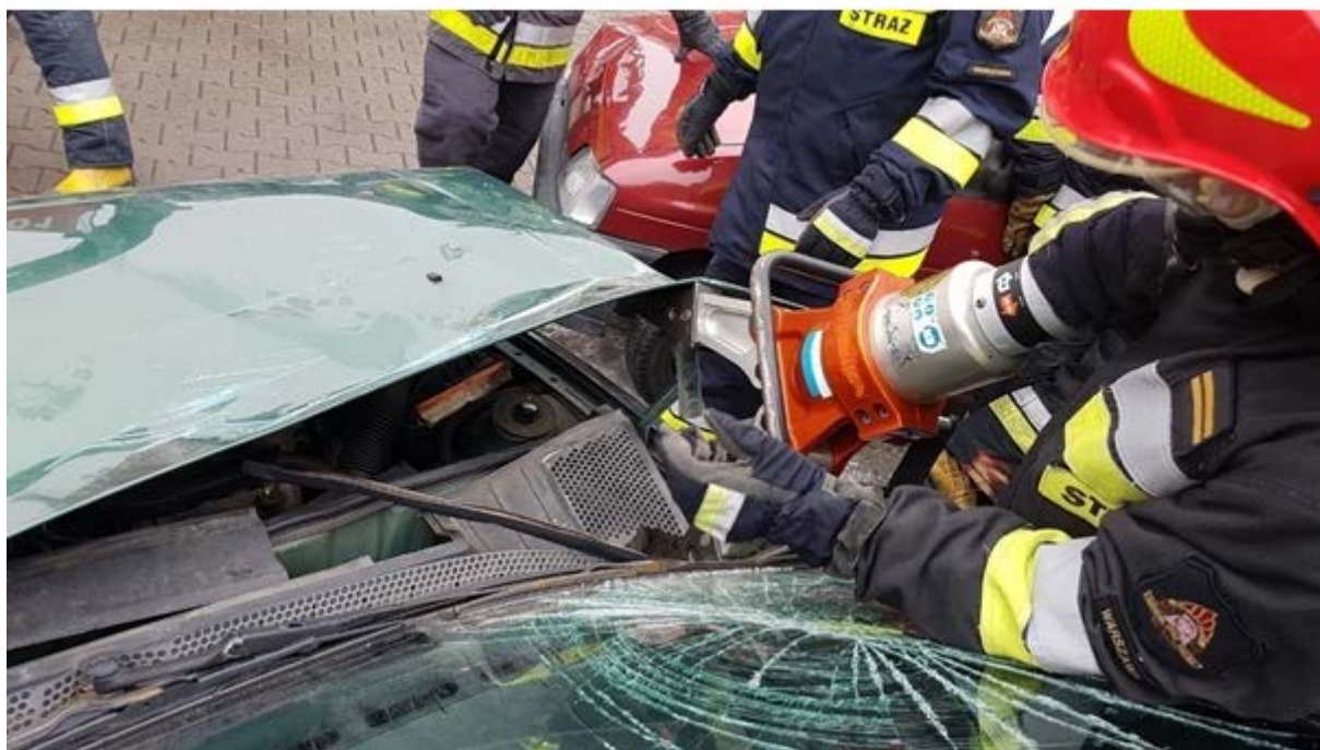
Rys.329. Wyrwanie zawiasów maski przy pomocy rozpieracza
