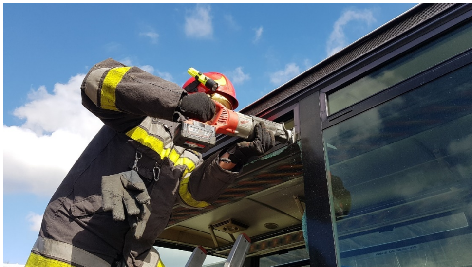
Rys. 407. Cięcie profili okiennych piłą szablą
