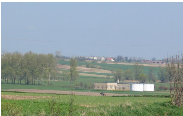
Ujęcie Bukownica, stacja uzdatniania wody
