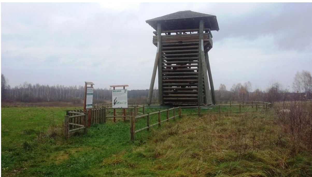
Ryc. 45. Wieża obserwacyjna "Orla Wieża" na terenie Nadleśnictwa Krynki (fot. M. Augustynowicz)
