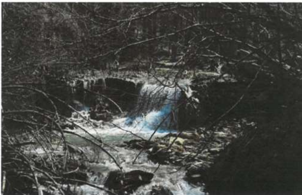
Zdjęcie nr 4b. Próg na potoku Kamionka w km 0+541, przy drodze leśnej, który powstał po powodzi 12.04.2009r., miejsce korekty ciek w oddz. 131a
