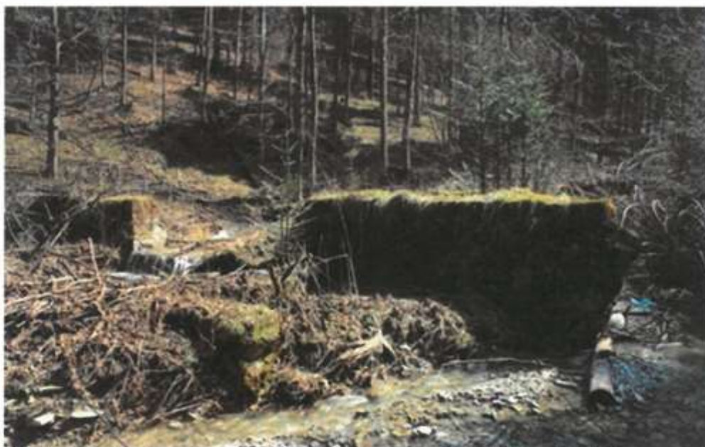
Zdjęcie nr 4a. Próg kamienno – betonowy z lat 70-tych w km 0+541 w oddz. 131 a - zaplanowano rozbiórkę i wykonanie bystrza oraz odtworzenie naturalnego biegu potoku - widok po powodzi 2009 r.
