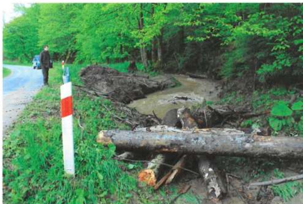
Zdjęcie nr 4. Przerwana ciągłość potoku Mszaniec - po zamuleniu przepustu potok popłynął rowem przydrożnym i drogą leśną.
