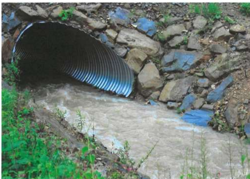
Zdjęcie nr 1b. Wlot przepustu w km 0+127 po przebudowie - widok po powodzi maj 2014r.
