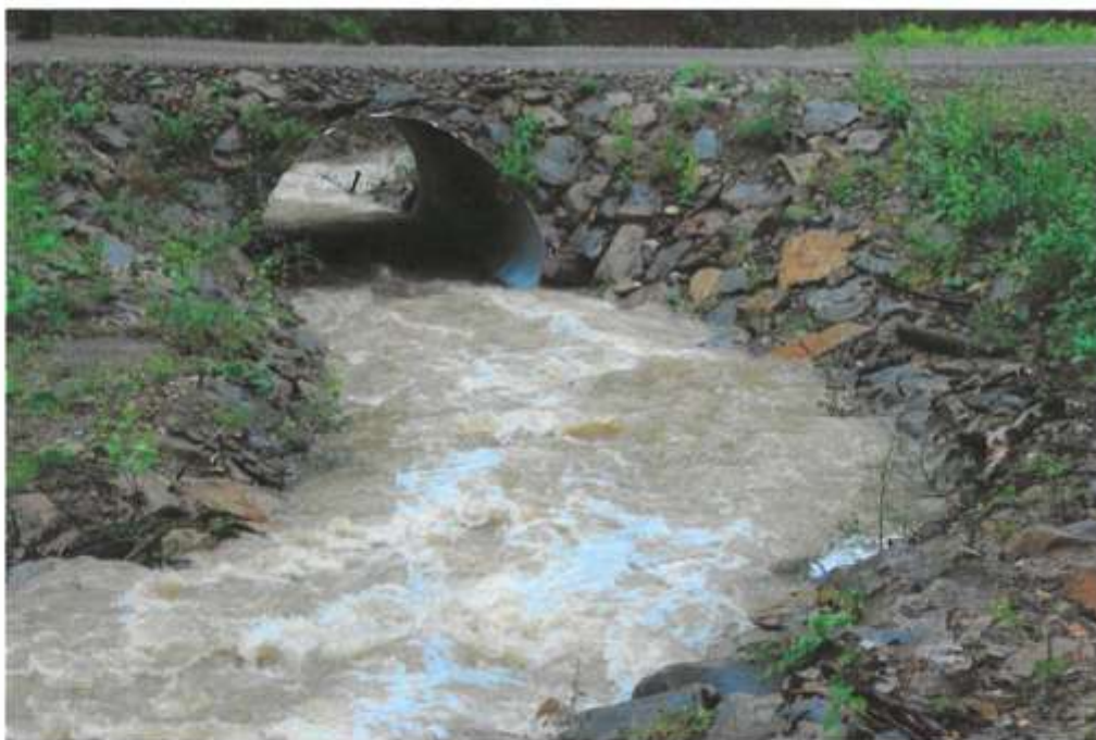
Zdjęcie nr 5b. Wlot przepustu w km 0+497 po przebudowie - widok po powodzi maj 2014r.
