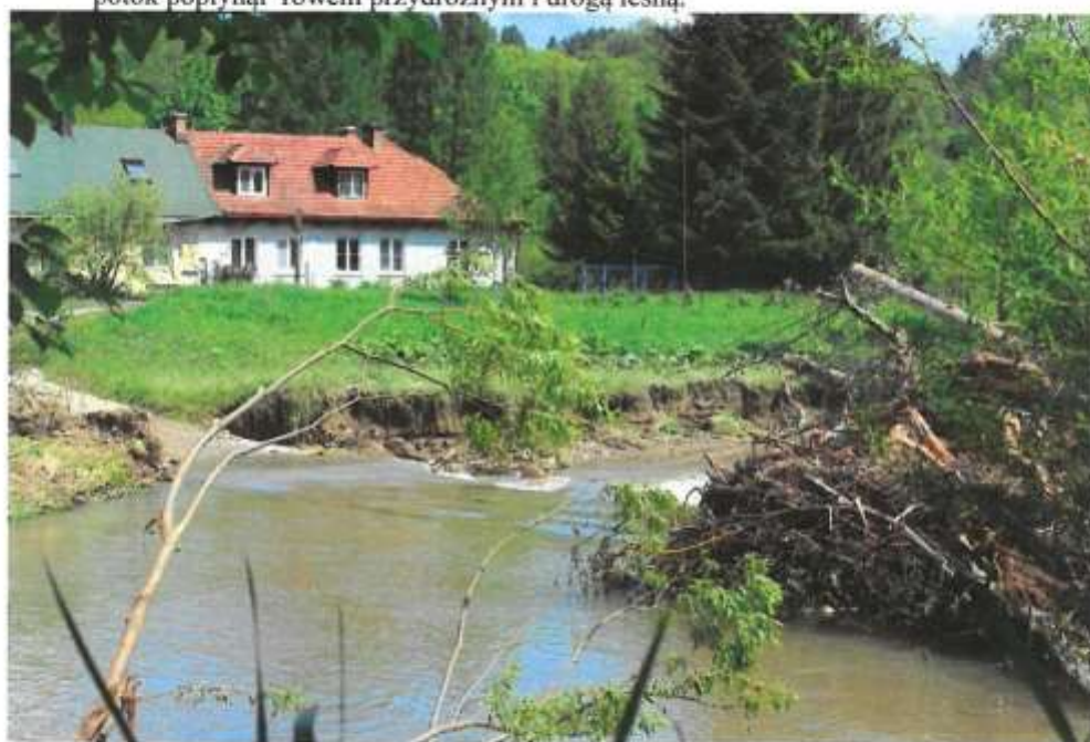
Zdjęcie nr 6. Hałda rumoszu drzewnego skierowała wody powodziowe rzeki Wiar w kierunku drogi powiatowej Bircza – Huwniki oraz zabudowań.
