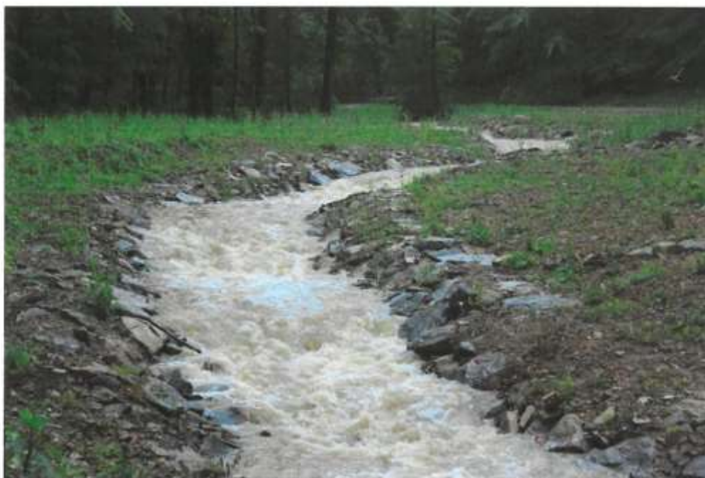
Zdjęcie nr 4c. Meander w miejscu stopnia betonowego i progu w km 0+541 - widok po powodzi maj 2014r.
