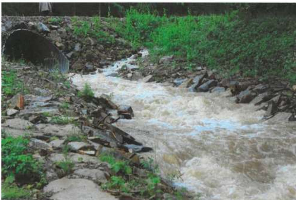
Zdjęcie nr 6b. Wylot przepustu w km 0+497 po przebudowie - widok po powodzi maj 2014r.
