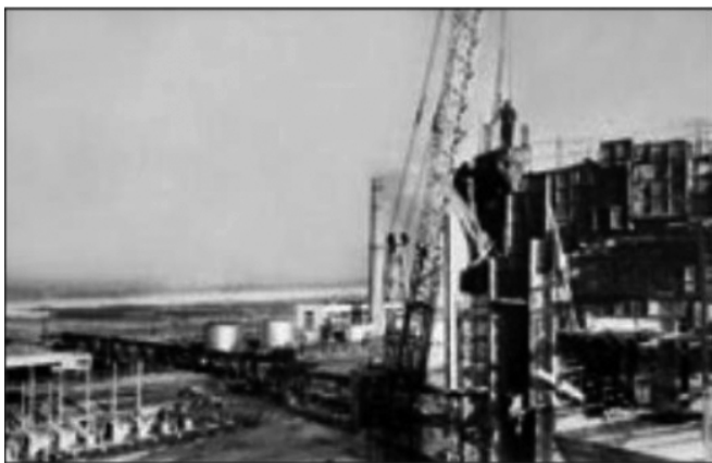
Rys. 1. Fotografia ukazująca budowę pierwszego bloku energetycznego w Czarnobylu (źródło: [2, s. 13]).
