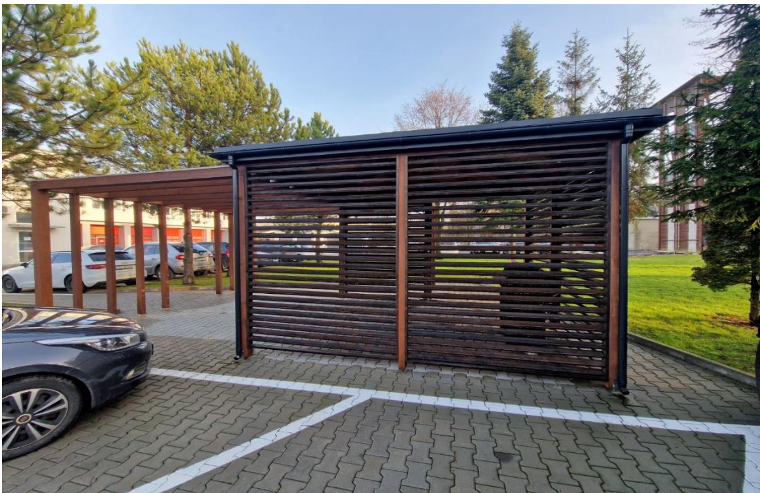
Zdjęcie 18. Zakończenie budowy altany.
