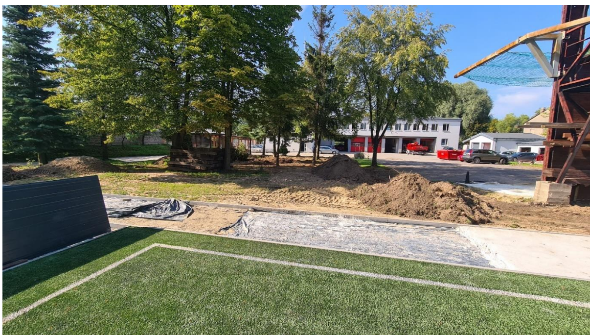
Zdjęcie 20. Przygotowanie terenu pod budowę bieżni przeznaczonej do ćwiczenia elementów sportu pożarniczego.
