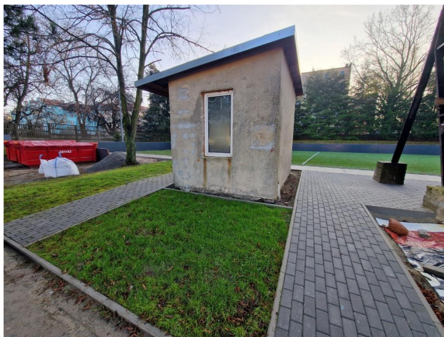
Zdjęcie 16. Prace remontowe pomieszczenia przeznaczonego na sprzęt ogrodniczy i inny.
