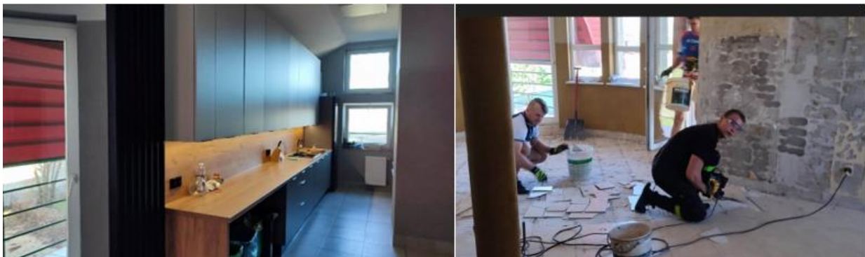
Zdjęcie 27. Modernizacja pomieszczenia kuchennego.
