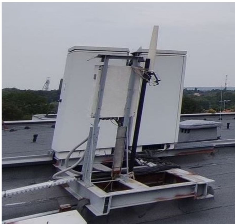
Rys. 2 Miejsce montażu SMS PEM – Szkoła Podstawowa nr 8 w Siemianowicach Śląskich
