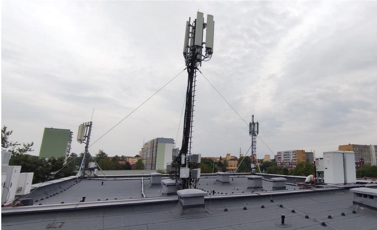
Rys. 3 Miejsce montażu SMS PEM – Szkoła Podstawowa nr 8 w Siemianowicach Śląskich – widok na SBTk
