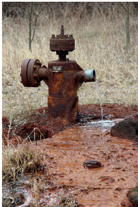
Fig. III.5. Niezagospodarowany otwór Frombork IGH-1 z niekontrolowanym wypływem wody w 2013 r. (fot. J. Sokołowski, 2013 r.)
