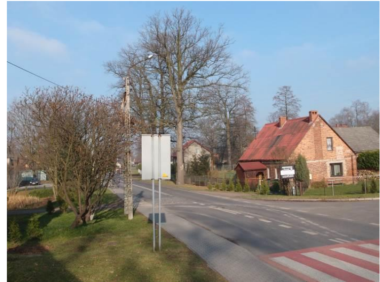
Fot. 5. Miedźna, RB2. ul. Wiejska w kierunku miejscowości Wola
