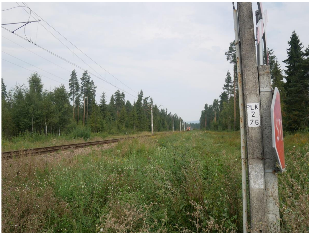
Fot. 2. Widoczność w porze dziennej z 5 m w kierunku zbliżającego się pociągu (z pozycji kierowcy samochodu osobowego)
