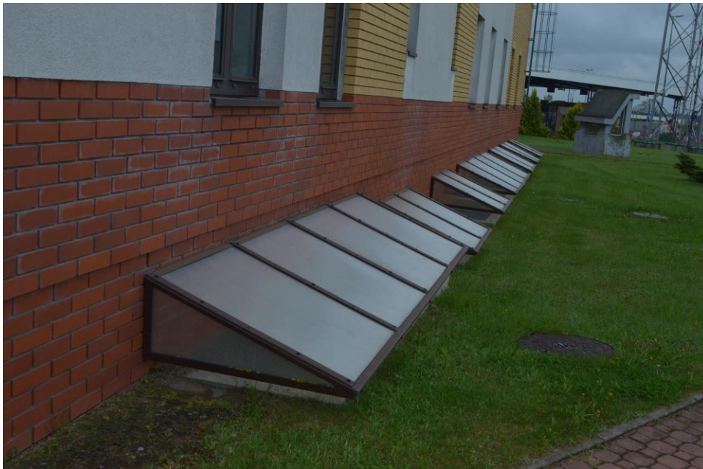
Fot. 3. Widoczne zadaszzenia studzienek doświetlających okna piwniczne z poliwęglanu oraz wykwyty solne na elewacji z cegły klinkierowej. Fot. M. Tur 2021
