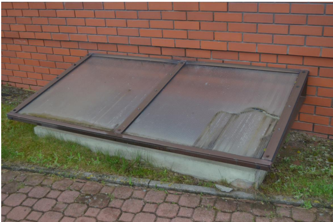
Fot. 4. Uszkodzone i zanieczyszczone płyty poliwęglanu.
