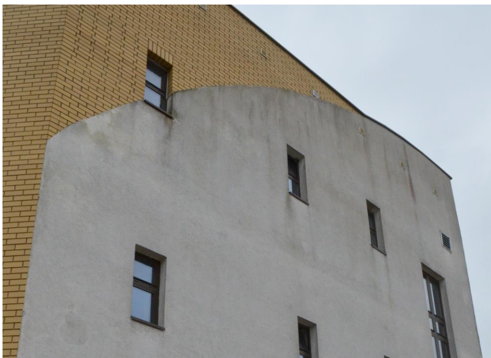
Fot. 2. Elewacja z wykończeniem tynkiem – widoczne zanieczyszczenia z wymywanych spoin elewacji klinkierowej. Fot. M. Tur 2021
