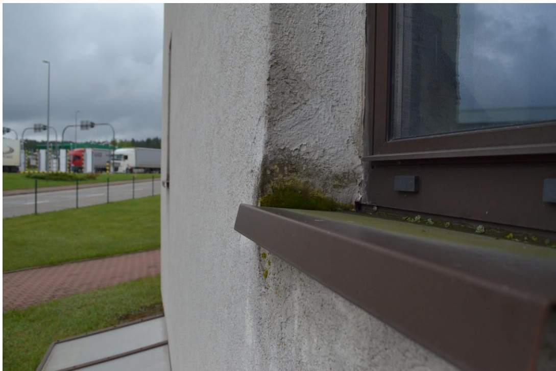
Fot.1. Mocowanie parapetów – widoczne zawilgocenie tynków ościeży przy parapetach zewnętrznych okien oraz naprawy tynku. Fot. M. Tur 2021
