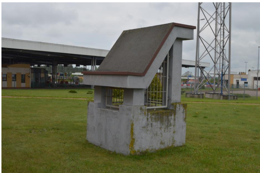
Fot. 6. Obudowa wylazu terenowego – widoczne wykwity glonów.
