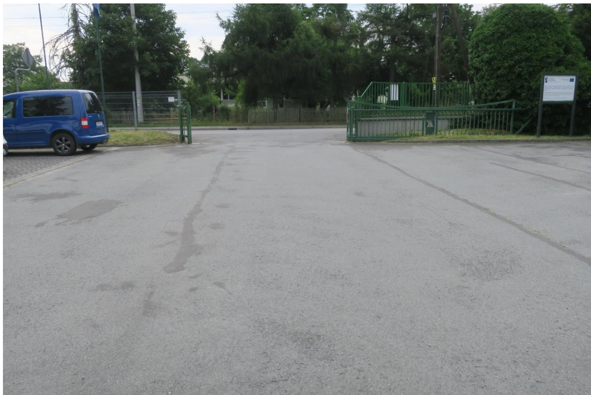
Fot. 3 – Plac na którym będzie montowane ogrodzenie
