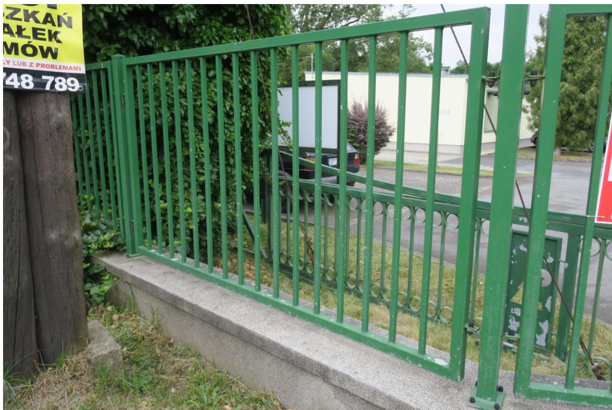
Fot. 2 – istniejący panel ogrodzeniowy – na wzór do wykonania nowego ogrodzenia
