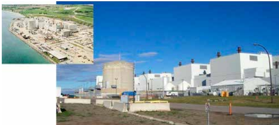
Fot. 1. Elektrownia jądrowa Darlington bloki 2, 3 i 4 oraz wieża próżniowa lokalizacji awarii, (zezwoleń OPG 2007)
