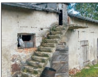
wady konstrukcyjne budynków, schodów, niezabezpieczone otwory zrzutowe
