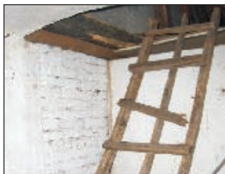
nieprawidłowo skonstruowane drabiny (brak zabezpieczeń przed przechyłem i osunięciem, zły rozstaw szczebli) lub ich zły stan techniczny
