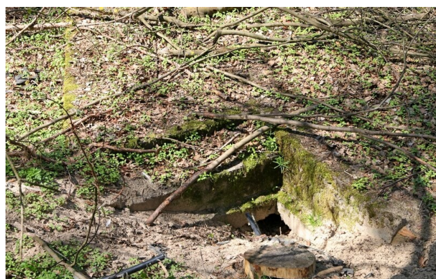
Zarośnięty fundament nieukończonego schronu nr 20
