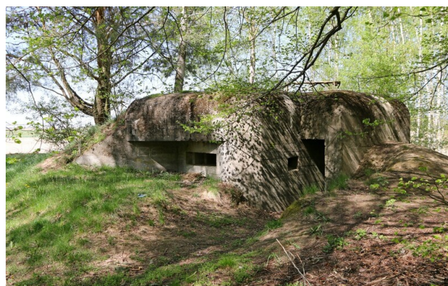
Schron nr 13, widoczna przelotnia osłaniająca wejście
