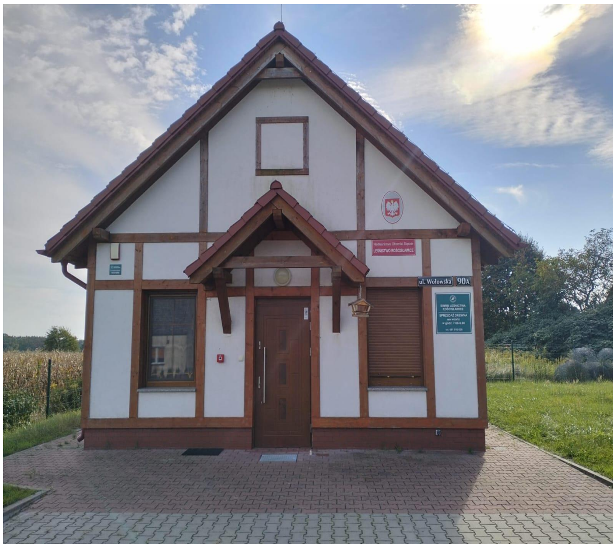
Zdjęcie 3. Budynek kancelarii leśnictwa Rościszawice wybudowany w 2016 r.
