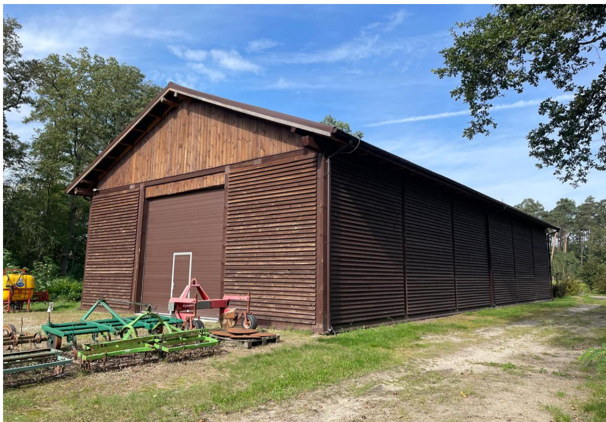
Zdjęcie 9. Budynek gospodarczy na Szkółce Leśnej w Jarach wybudowany w 2019 r.
