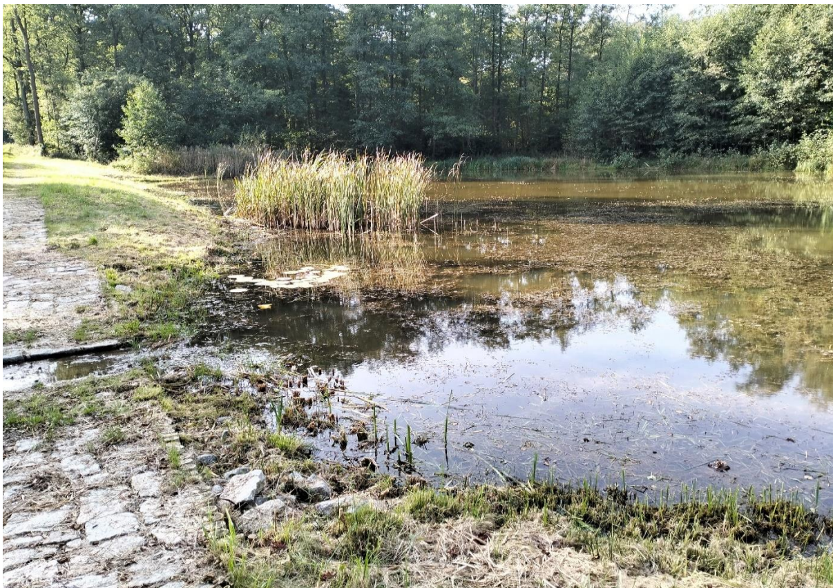
Zdjęcie 13. odbudowany w 2020 r. zbiornik MRN w leśnictwie Osolin
