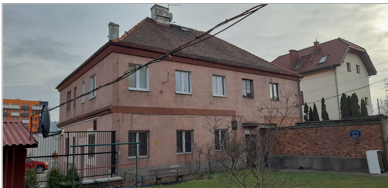
Zdjęcie nr 2 – budynek „D” - widok od strony północnej
