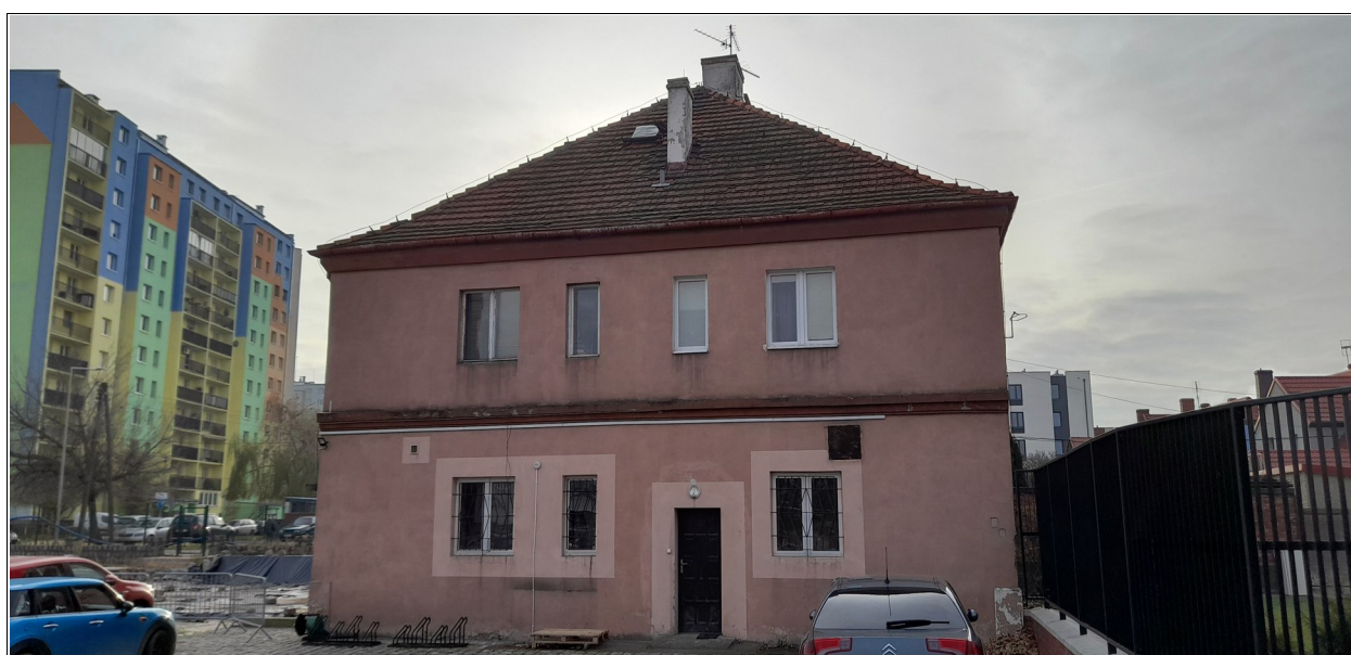
Zdjęcie nr 3 – budynek „D” - widok od strony północnej
