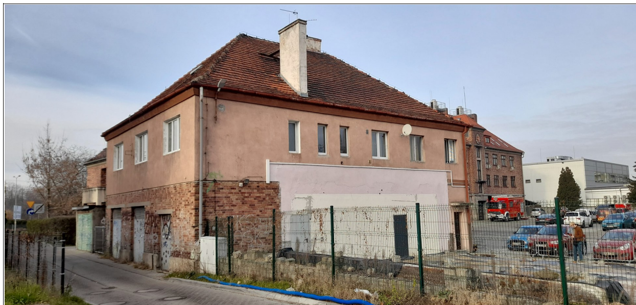
Zdjęcie nr 1 – budynek „D” - widok od strony południowo-wschodniej
