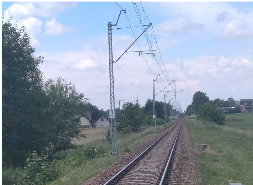
Fot. 3. Wyry, RB1. Linia kolejowa nr 169 w kierunku Orzesza.
