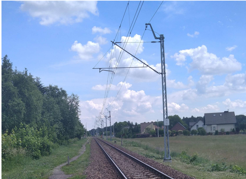
Fot. 2. Wyry, RB1. Linia kolejowa nr 169 w kierunku Tych.
