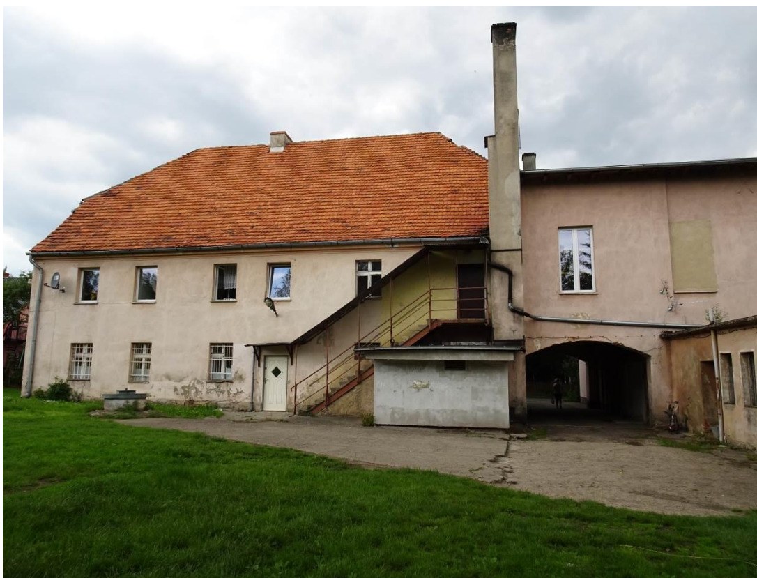
Budynek świetlicy w Lipie, na strychu którego mieści się kolonia rozrodcza nocka dużego, 15.06.2020 (J. Furmankiewicz)
