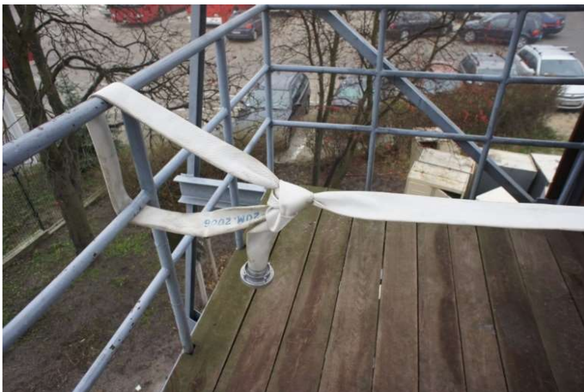
Rys. 28). Stanowisko do samoratowania z WP 52
