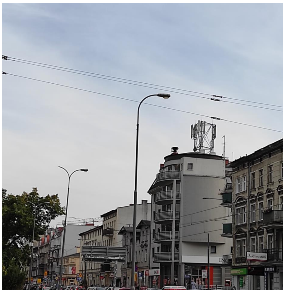
Fot. 1: Widoki anten stacji bazowej: ID: 1121, zlokalizowanej: ul. Stanisława Staszica 2, Poznań
