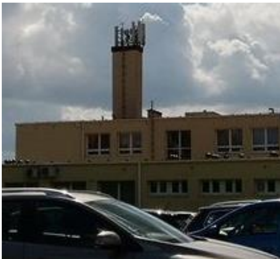
Fot. 1: Widok anten stacji bazowej: ID: OLS1037D, zlokalizowanej pod adresem: ul. Mariańska 1, 10-052 Olsztyn
