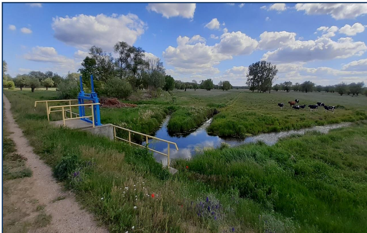
Rycina 12 Zastawka z zamknięciem zasuwowym na obiekcie melioracyjnym Troszyn w okolicach Płocka (woj. mazowieckie) (fot. B. Kierasiński)
