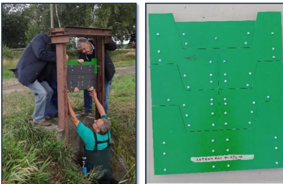
Rycina 11 Zestaw przelewów i jego montaż w cieku. Projekt INOMEL
