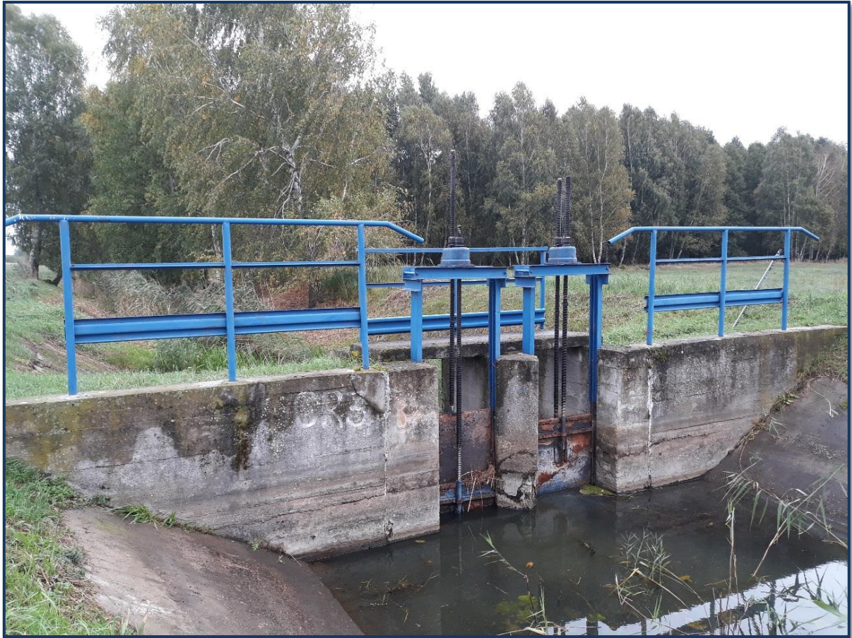
Rycina 15 Dwuprzęsłowy jaz piętrzący z zamknięciami zasuwowymi na cieku Czarny Rów, woj. kujawsko – pomorskie (fot. B. Kierasński)
