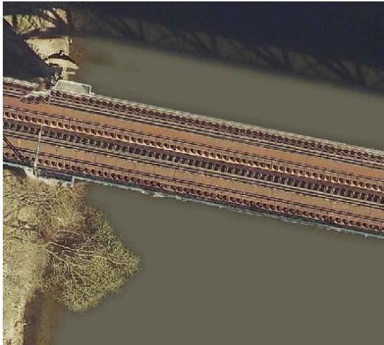
Rys. 9-10 Torowisko kolejowe na podbudowie bezpodsypkowej na wiadukcie (N)
