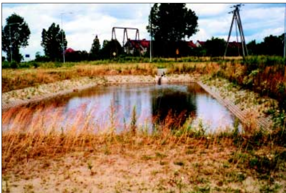
Fot. 4. Zbiornik infiltracyjno-odparowujący w systemie odwadniającym węzeł drogowy (fot. H. Sawicka-Siarkiewicz)
