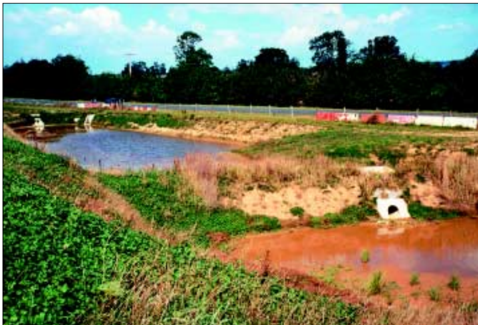
Fot. 3. Układ zbiorników retencyjno-infiltracyjnych w systemie odwodnienia autostrady (fot. H. Sawicka-Siarkiewicz)
