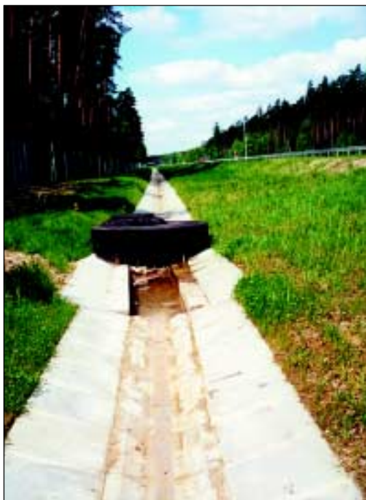
Fot. 2. Przyautostradowy rów odwadniający uszczelniony (fot. H. Sawicka-Siarkiewicz)
