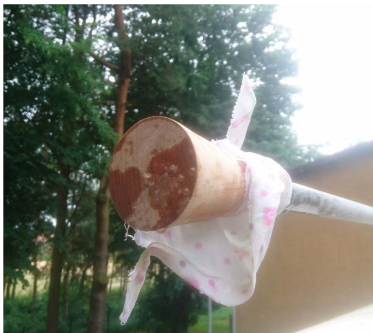
Fot. 34-36. Uszczelnianie rury i zbiornika kołkiem drewnianym. Źródło własne
