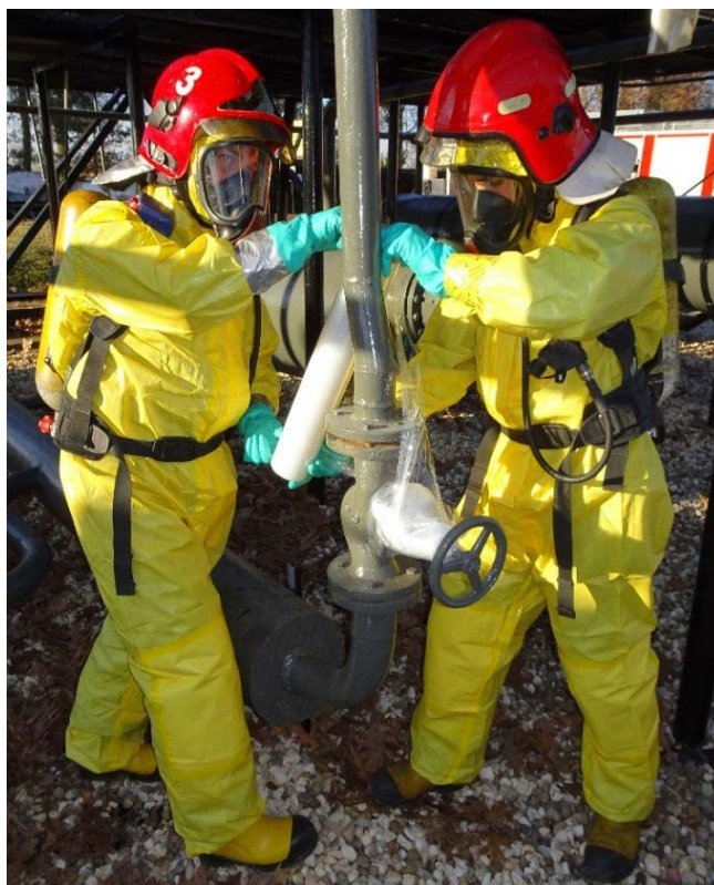
Fot. 32. Uszczelnianie rury folią Strech. Źródło własne
