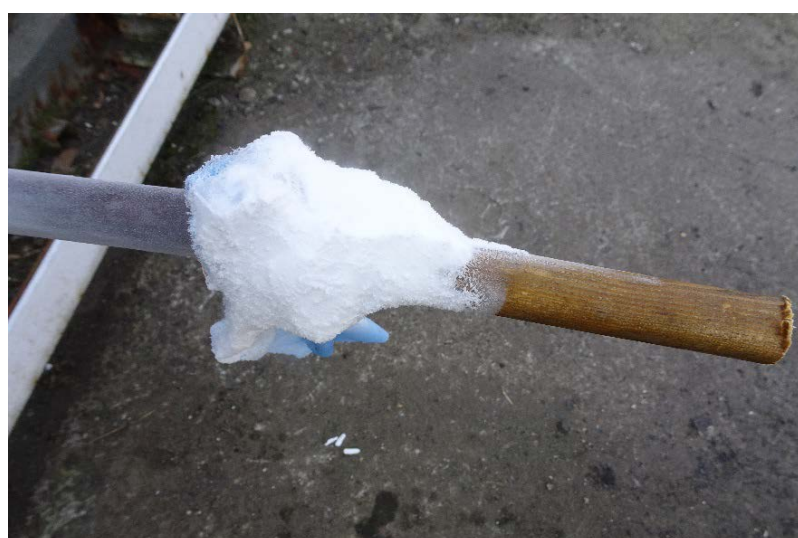
Fot. 37-39. Uszczelnienie przy użyciu gaśnicy z CO 2 . Źródło własne
