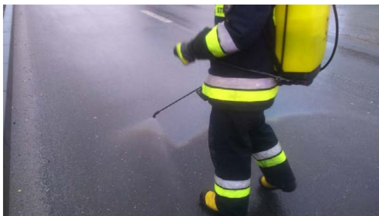
Fot. 47. Dyspergowanie cienkiej plamy substancji ropopochodnej. Źródło własne
