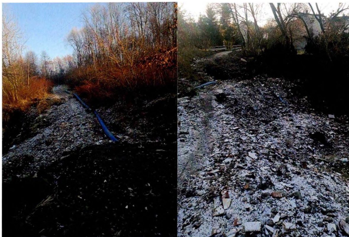
Rys. 24 Stan drogi w Lednicy Górnej w rejonie ul. Solarskiego i rzeki Świdówki
