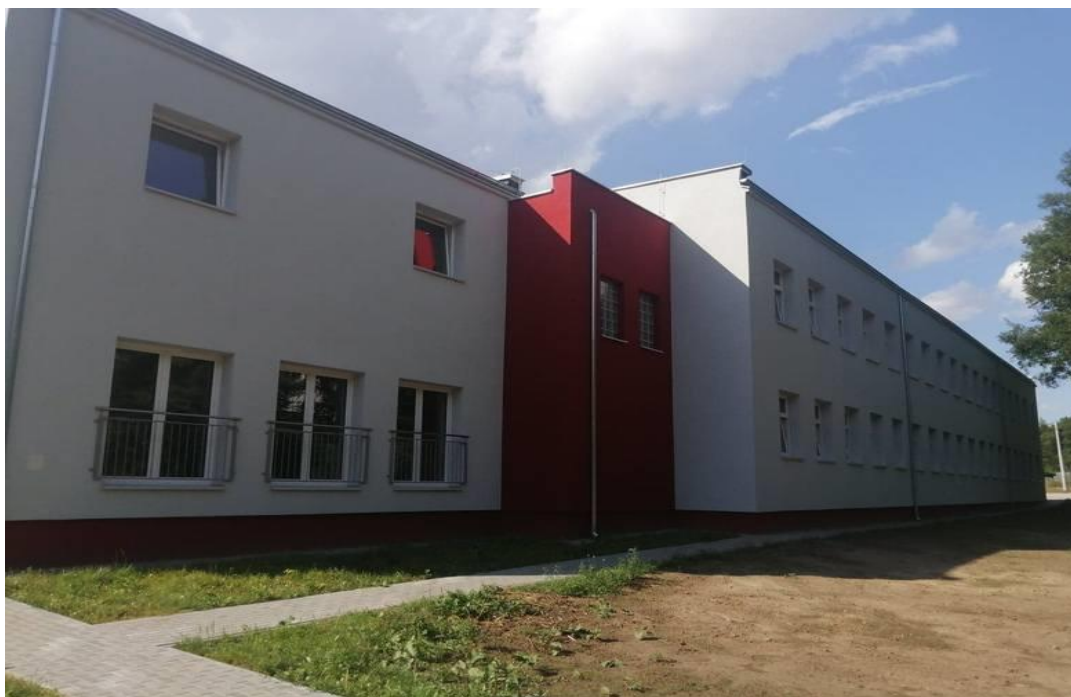
Zdjęcie 7. Budynek socjalny w miejscowości Krępa gm. Iwaniska
