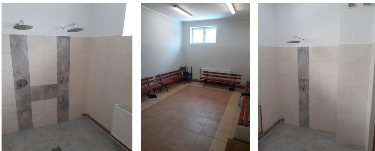
Zdjęcie 16. Pomieszczenia sanitarno-higieniczne OKS w Opatowie po remoncie
