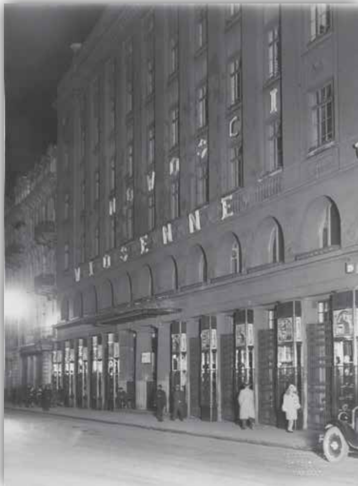
Warszawa, Budynek Domu Towarowego Braci Jabłkowskich przy ul. Brackiej w Warszawie (NAC, sygn. 1-G-5871-1).
