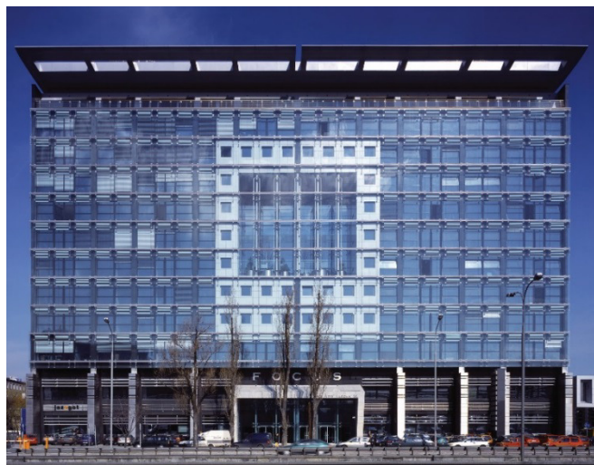
Rys. 1.10 Budynek biurowy FOCUS[36]
