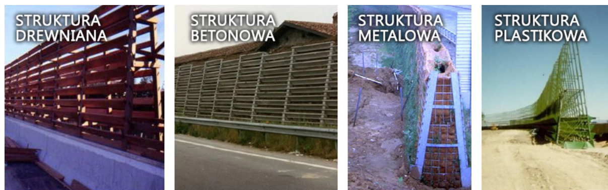
Rys. 4.5. Niekonwencjonalne ekrany akustyczne – Struktury barier biologicznych [9]
