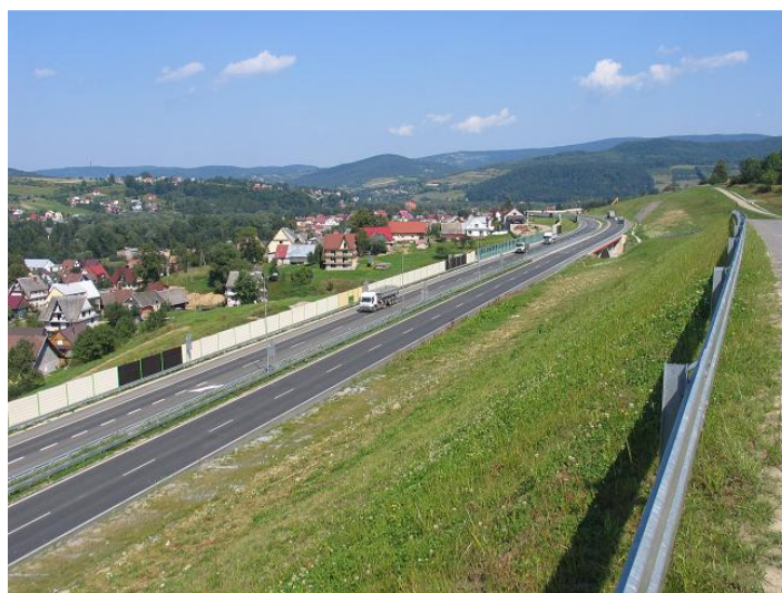
Rys. 3.5 Przebieg drogi w lokalizacji stokowej
