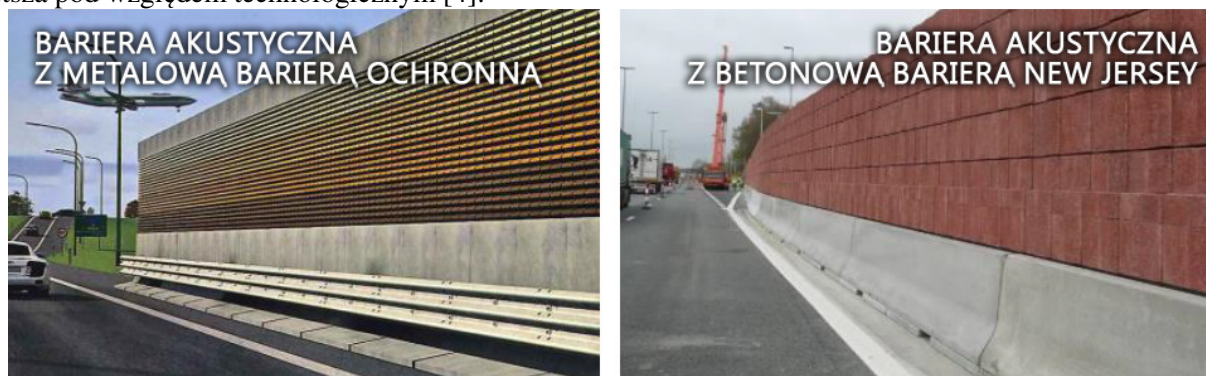
Rys. 4.7. Niekonwencjonalne ekrany akustyczne – Wolnostojące zintegrowane bariery dźwiękowe i bariery bezpieczeństwa [4]
