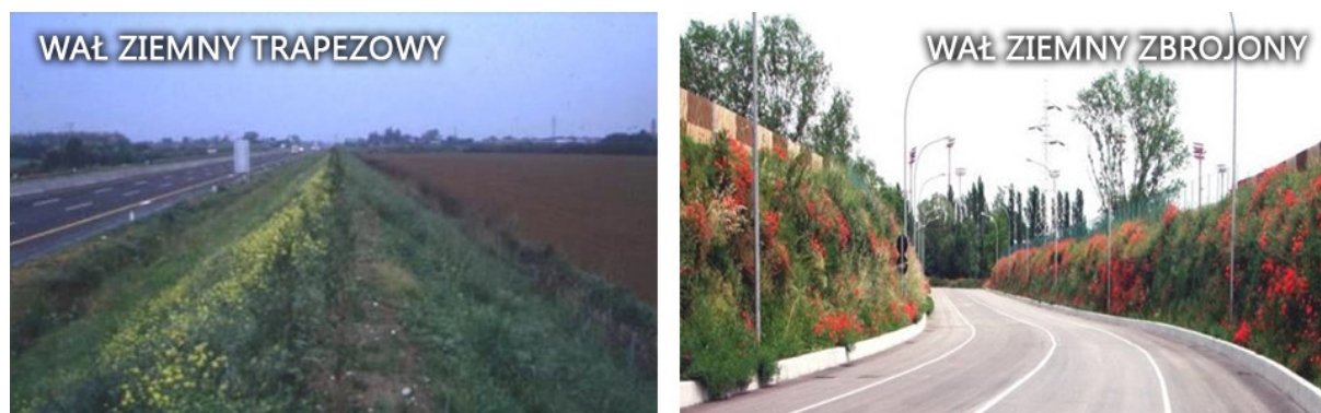
Rys. 4.4. Niekonwencjonalne ekrany akustyczne – Wały ekrano-ziemne [10]
