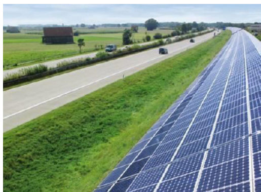
Rys. 4.8. Niekonwencjonalne ekrany akustyczne – Ekrany z panelami fotowoltaicznymi [9]
