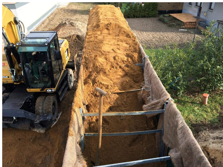
Rys. 1.4 Wał ziemny w trakcie budowy[39]
