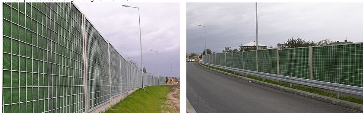
Rys. 4.6. Niekonwencjonalne ekrany akustyczne – Zielona ściana [9]
