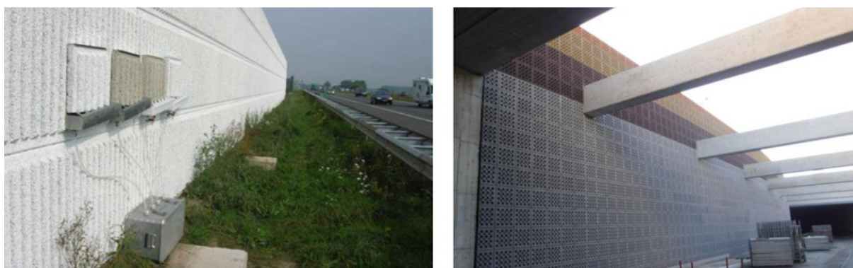
Rys. 4.10. Niekonwencjonalne ekrany akustyczne – Ekrany z powłoką TiO_2 [9]
