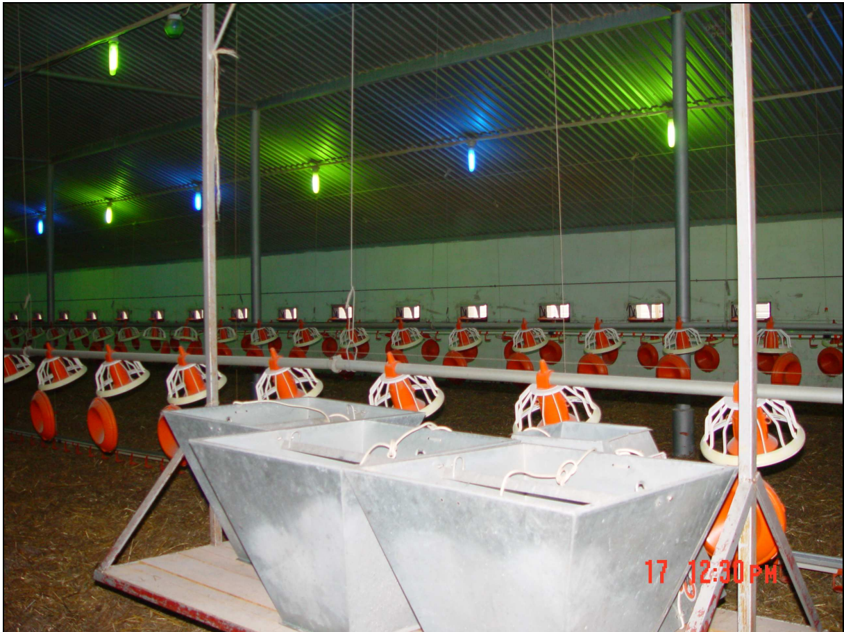
Rys. 3.2.5-1. Wnętrze kurnika przystosowanego do intensywnego chowu brojlerów – widoczne oświetlenie stosowane podczas chowu, na pierwszym planie kosz zasypowy wraz z liniami paszowymi, na których zamocowano karmidła.
