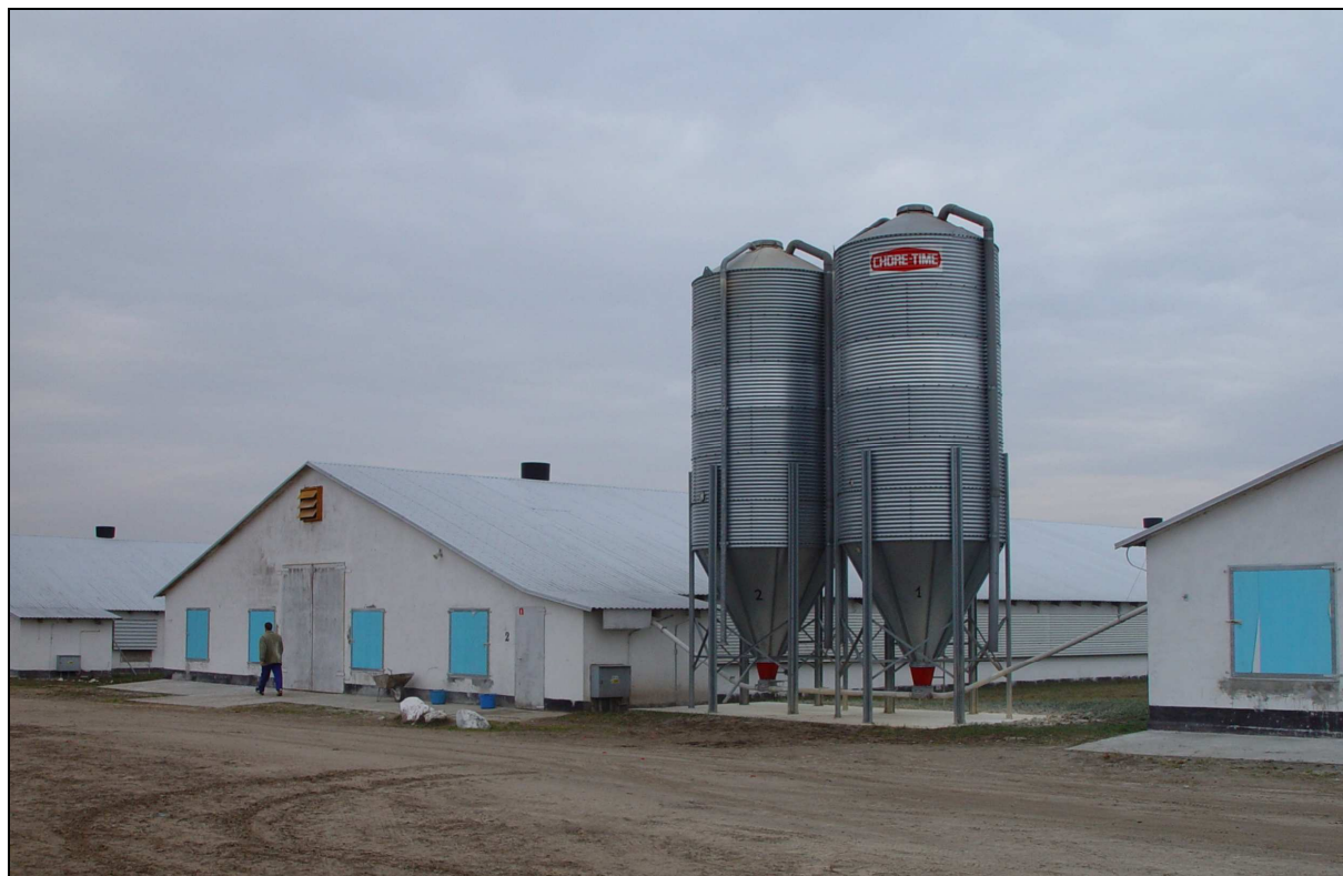
Rys. 3.2.6-1. Silosy paszowe zlokalizowane na zewnątrz budynków kurników.
