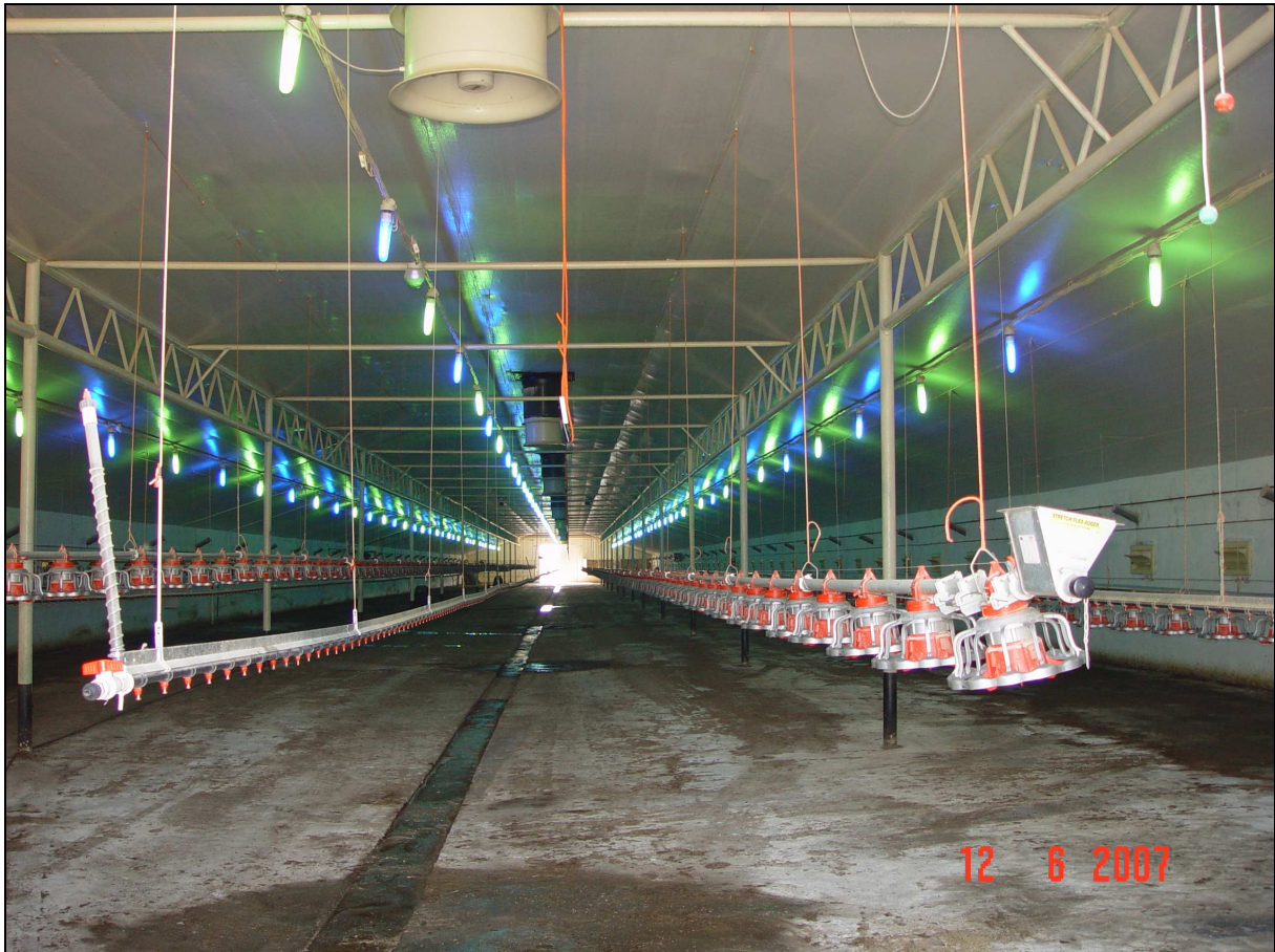
Rys. 3.2.7-1. Wnętrze niezasiedlonego kurnika przystosowanego do intensywnego chowu brojlerów – widoczne linie do pojenia (pierwsza po lewej) oraz linie paszowe (pierwsza po prawej).
