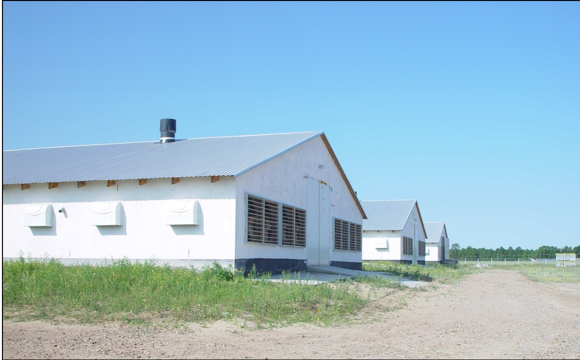
Rys. 3.2.4-1. Budynki kurników przeznaczonych do intensywnego, ściółkowego chowu brojlerów. Widoczne wentylatory dachowe, szczytowe oraz otwory nawiewne.
