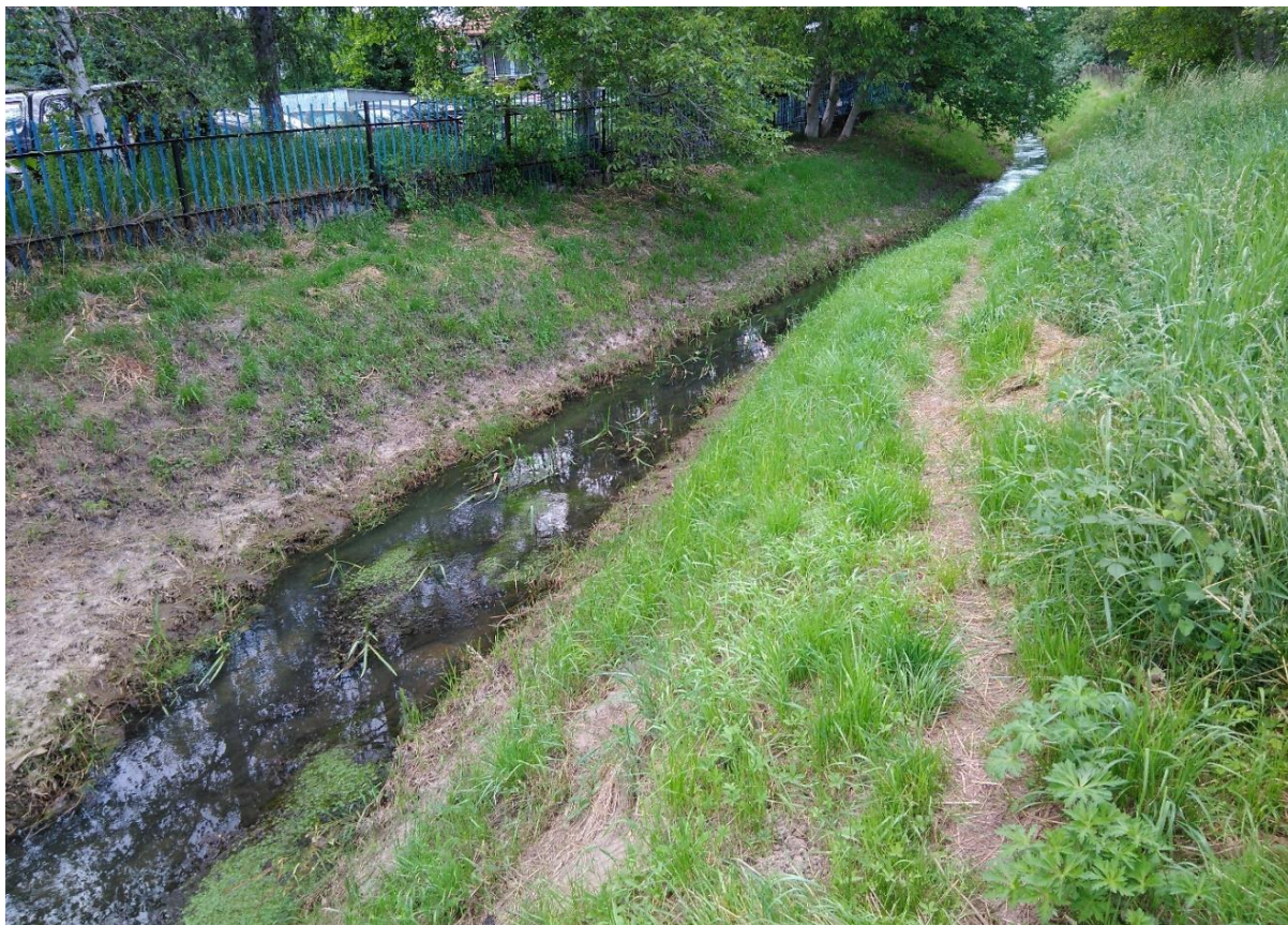
Zdjęcie nr 3: Kontrakt na roboty 3A.6 - koryto kanału Lesisko – Źródło – opracowanie własne
