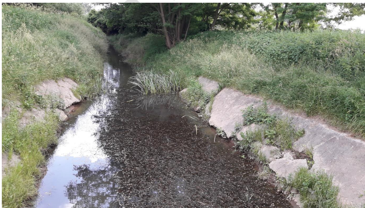
Zdjęcie nr 2: Kontrakt na roboty 3A.6 - koryto kanału Lesisko – Źródło – opracowanie własne
