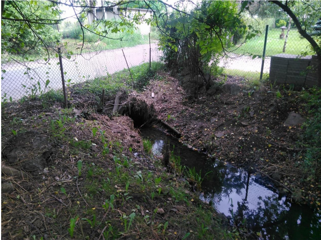
Zdjęcie nr 7: Kontrakt na roboty 3A.6 - koryto kanału Lesisko – Źródło – opracowanie własne
