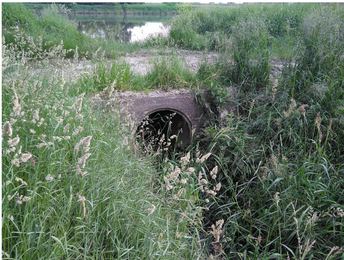
Zdjęcie nr 1: Kontrakt na roboty 3A.6 – przepust wałowy, którym kanał Lesisko odprowadza wody do rz. Wisły
