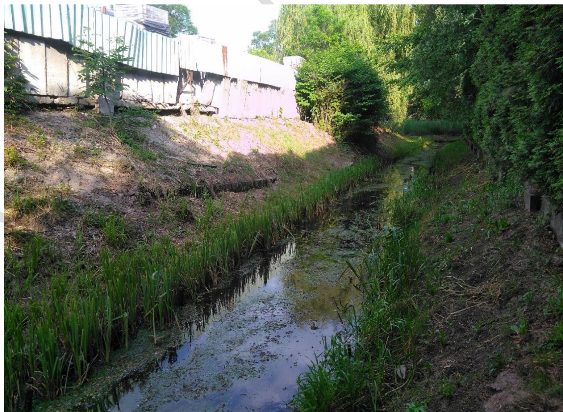
Zdjęcie nr 6: Kontrakt na roboty 3A.6 - koryto kanału Lesisko – Źródło – opracowanie własne
