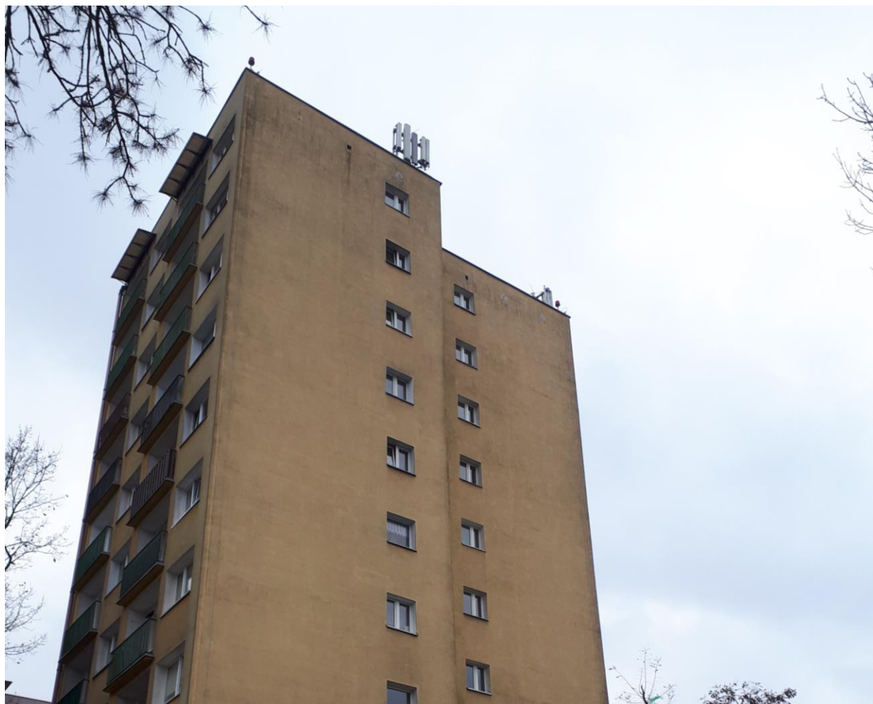
Fot. 1: Widok anten stacji bazowej: ID: LOD1160, zlokalizowanej: ul. Rejtana 8, Łódź
