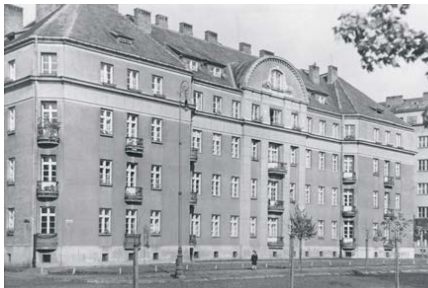
ul. Pługa 1/3 w Warszawie, 1937, fot. APW
