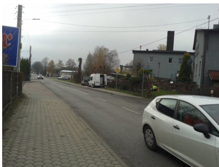
Fot. 10. Myszków, RB4. Badany odcinek ul. Słowackiego w kierunku centrum miasta
