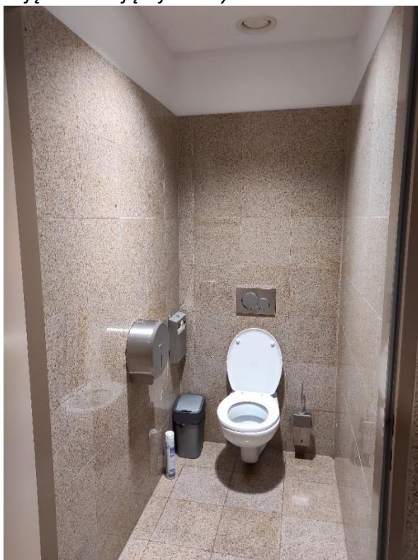
Zdjęcia istniejącej kabiny WC:
