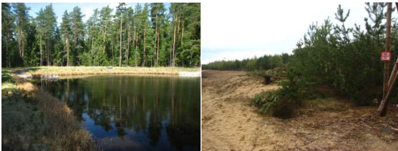
Zdjęcie 17. ŹRÓDŁA WODY DO CELÓW PPOŻ ZBIORNIK NAZIEMNY I PODZIEMNY(FOTO. J. LISZCZYK)
