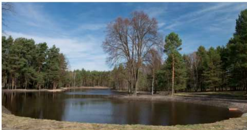
Fot. nr 2. Zbiornik retencyjny "Jezioro" (rok 2013).
