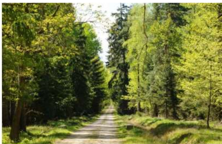
Fot. nr 4. Zmodernizowany dojazd pożarowy "Droga Kątowska" (lata 2005-2007).
