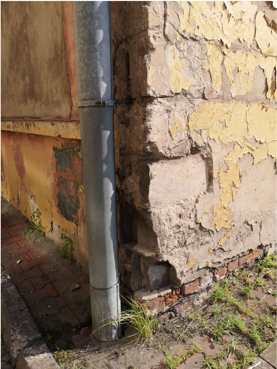
Fot.21 teren za budynkiem, budynek po Archiwum Narodowym planowany do rozbiórki.
