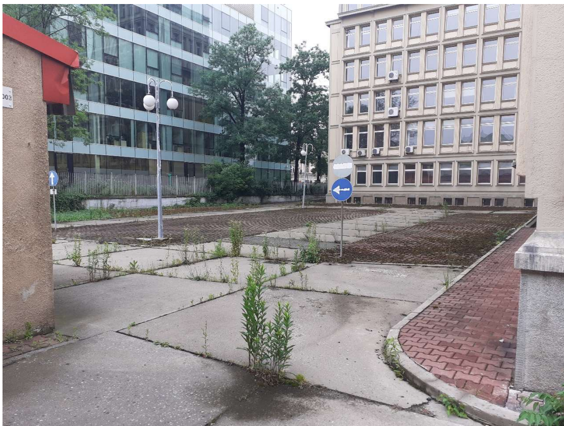
Fot.35 teren za budynkiem, zdegradowana nawierzchnia - uskoki pomiędzy płytami, brak odpowiedniego odwodnienia terenu, widoczne zagłębienia ze śladami po kałużach.
