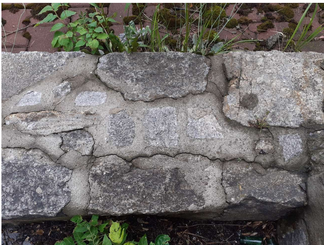
Fot.57 teren za budynkiem, zdegradowane murki terenowe do renowacji – widok z góry.
