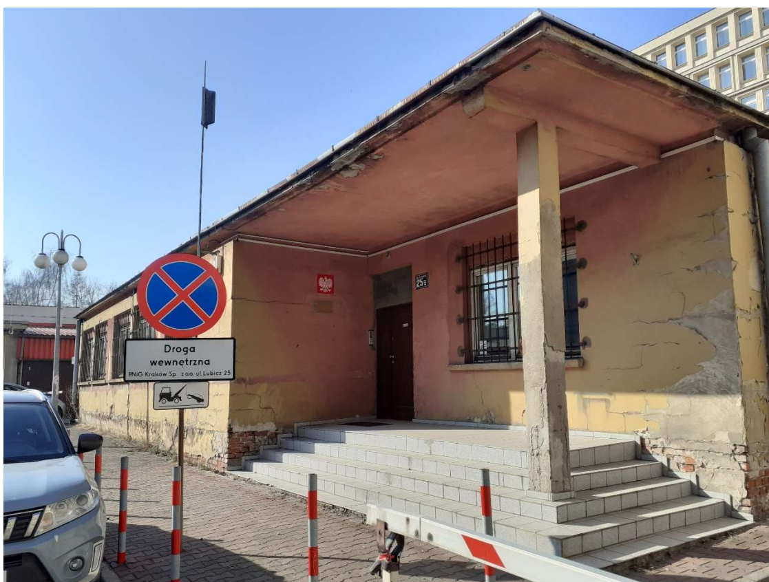
Fot.19 teren za budynkiem, budynek po Archiwum Narodowym planowany do rozbiórki.
