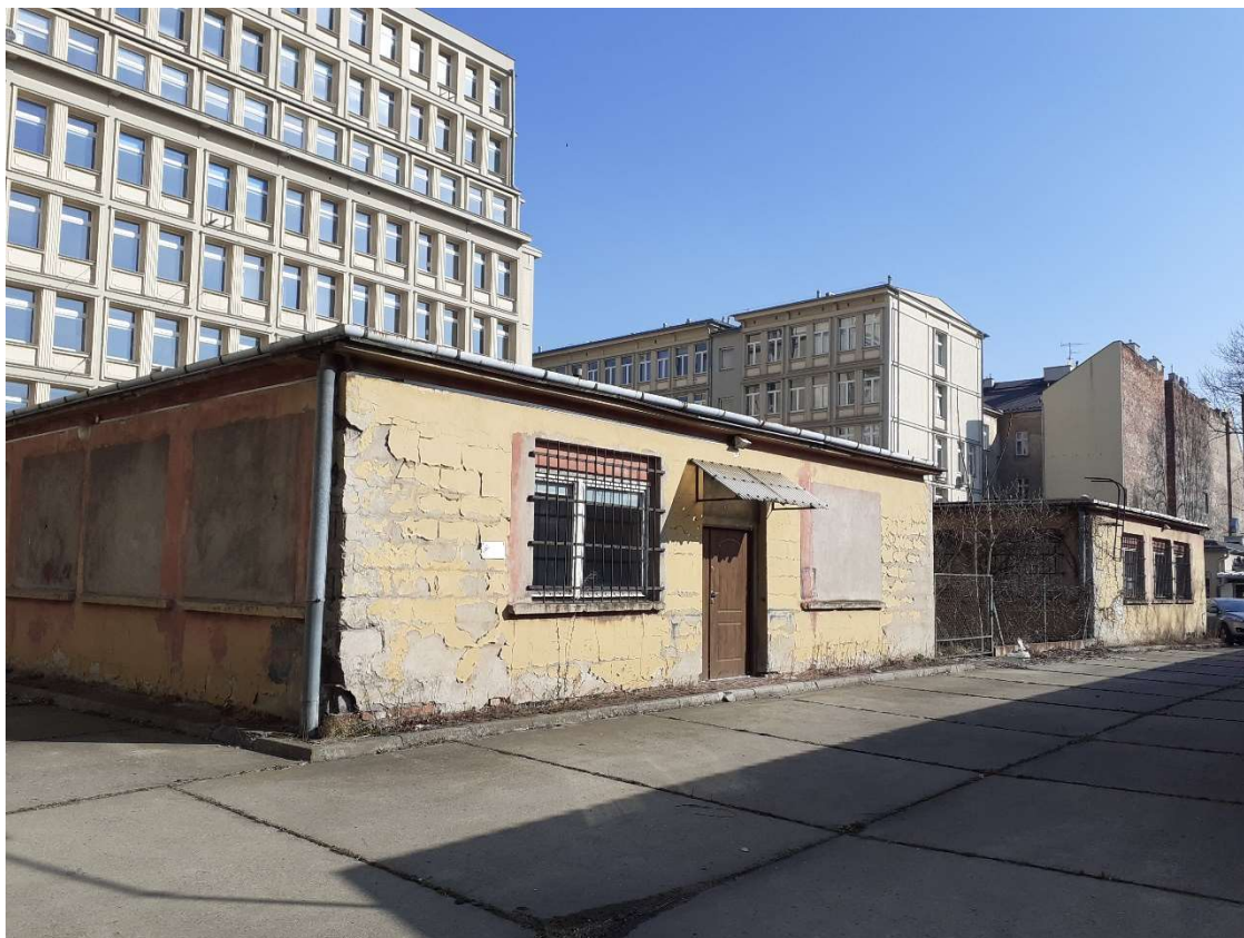
Fot.17 teren za budynkiem, budynek po Archiwum Narodowym planowany do rozbiórki.
