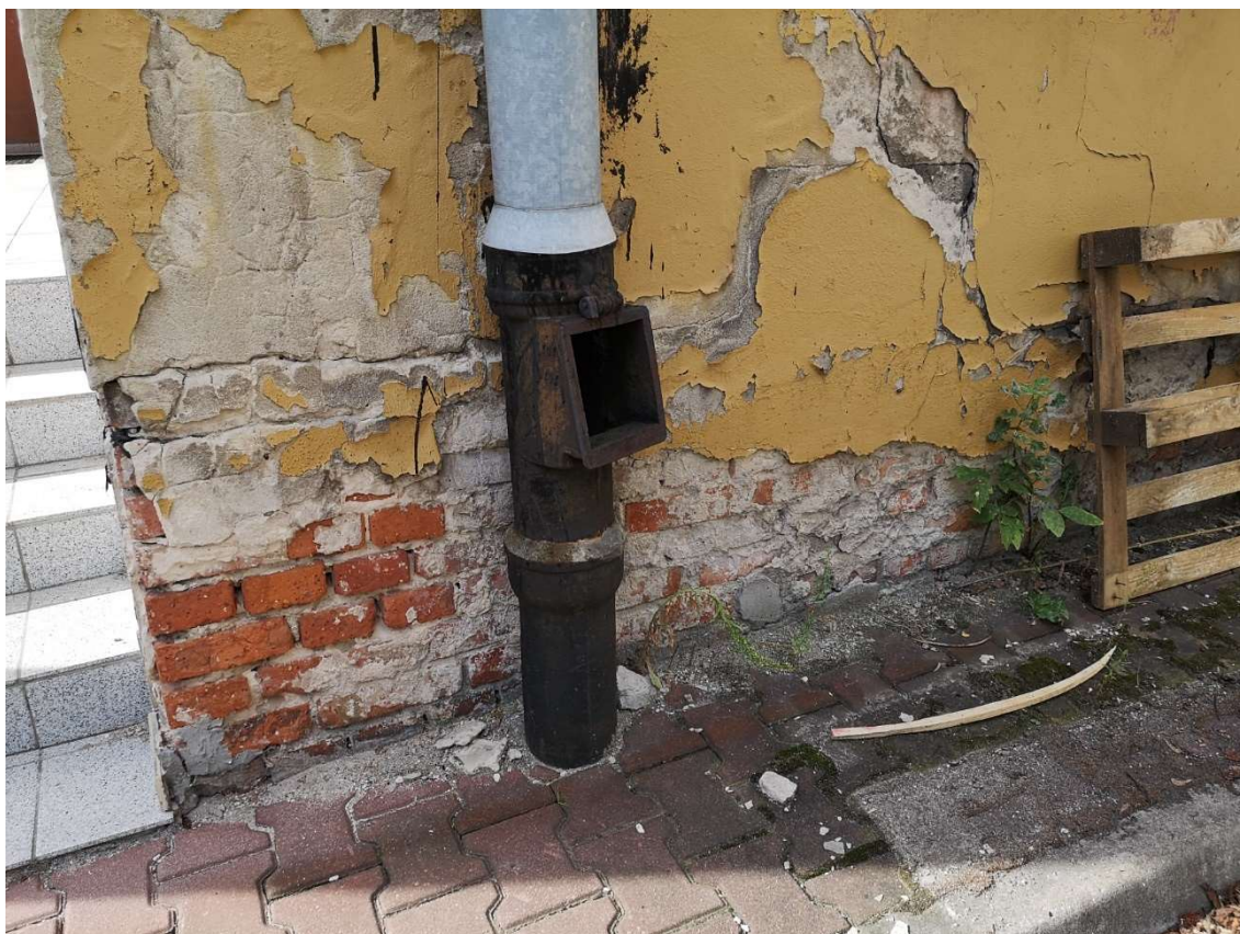
Fot.22 teren za budynkiem, budynek po Archiwum Narodowym planowany do rozbiórki.
