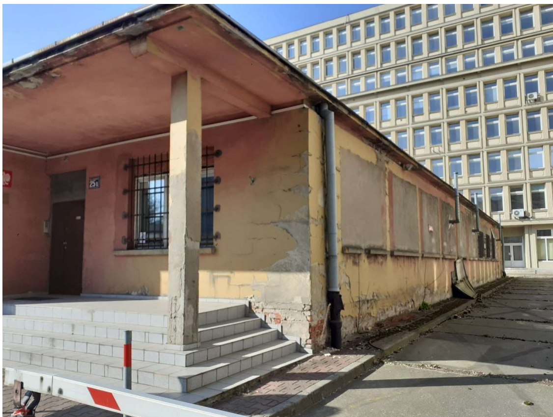
Fot.18 teren za budynkiem, budynek po Archiwum Narodowym planowany do rozbiórki.
