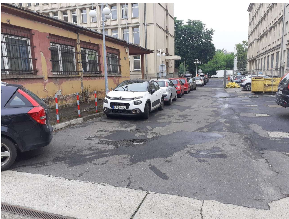
Fot.30 teren za budynkiem, zdegradowana nawierzchnia, budynek Archiwum Narodowego planowany do rozbiórki.
