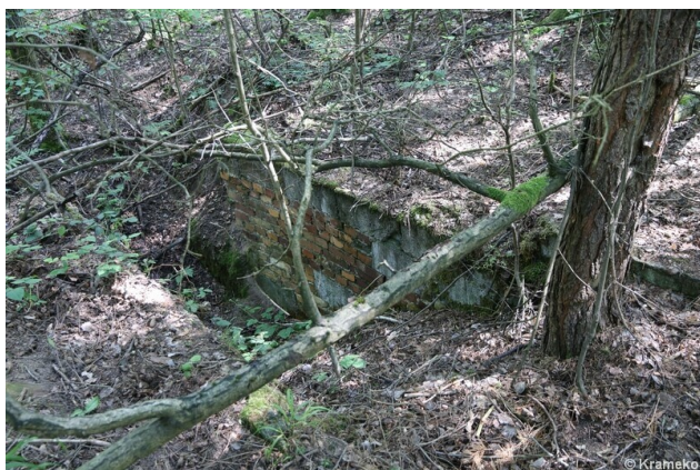
Wejście do zasypanego tunelu (być może obudowa szybu upadłego)
