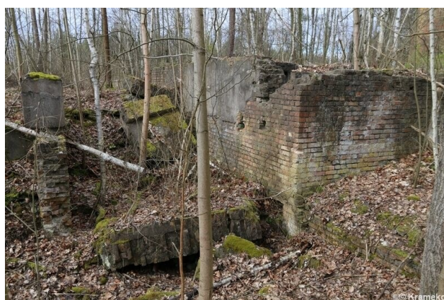
Trzebów, dawny obiekt przemysłowy
