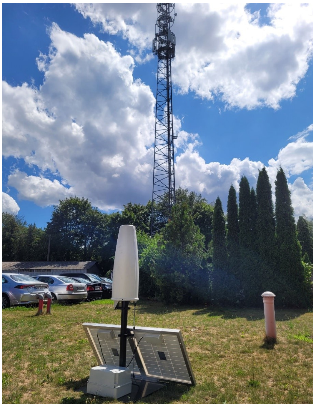
Rys. 6 Lokalizacja pomiarowa – TBS Zieleń Miejska w Pruszkowie
