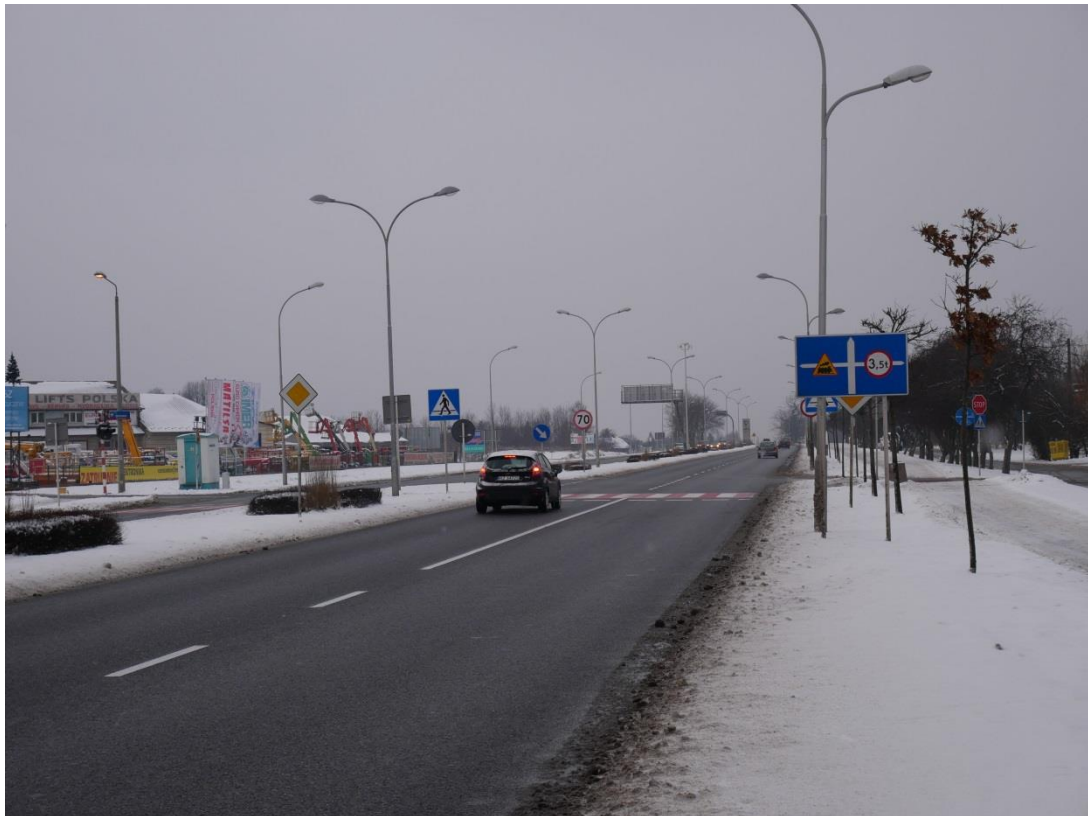
Fot. 6, 7, 8. Oznakowanie przejazdu od strony ul. Warszawskiej
