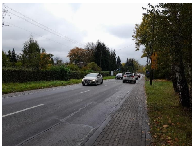
Fot. 2. Sosnowiec, RB1, badany odcinek ul. Teofila Lenartowicza w kierunku skrzyżowania z ul. Wiejską.
