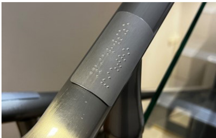
Zdjęcie 5 : Oznaczenia dotykowe zawierające informacje w alfabecie Braille'a zamontowane na poręczy w Sądzie Apelacyjnym w Poznaniu
