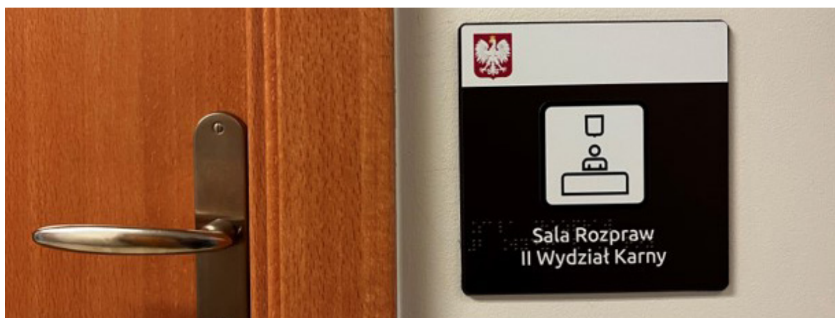
Zdjęcie 2 : Informacja dotykowa przy drzwiach wejściowych znajdująca się na ścianie, po stronie klamki – Sąd Apelacyjny w Poznaniu
