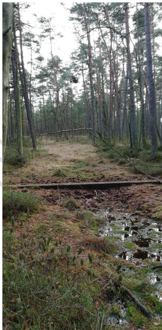
Budowla spowalniająca odpływ wody z rezerwatu (fot. M. Lecyk)
