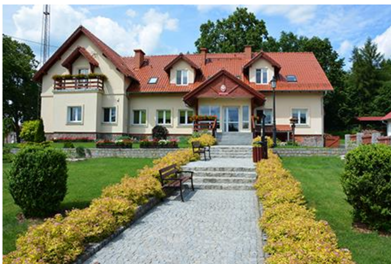
Budynek Nadleśnictwa w Dobrocinie (fot. Nadleśnictwo Dobrocin)
