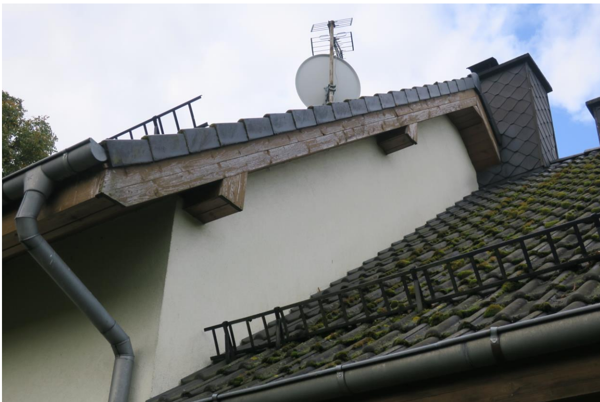
Fot. 4 – podbitka i elewacja do malowania
