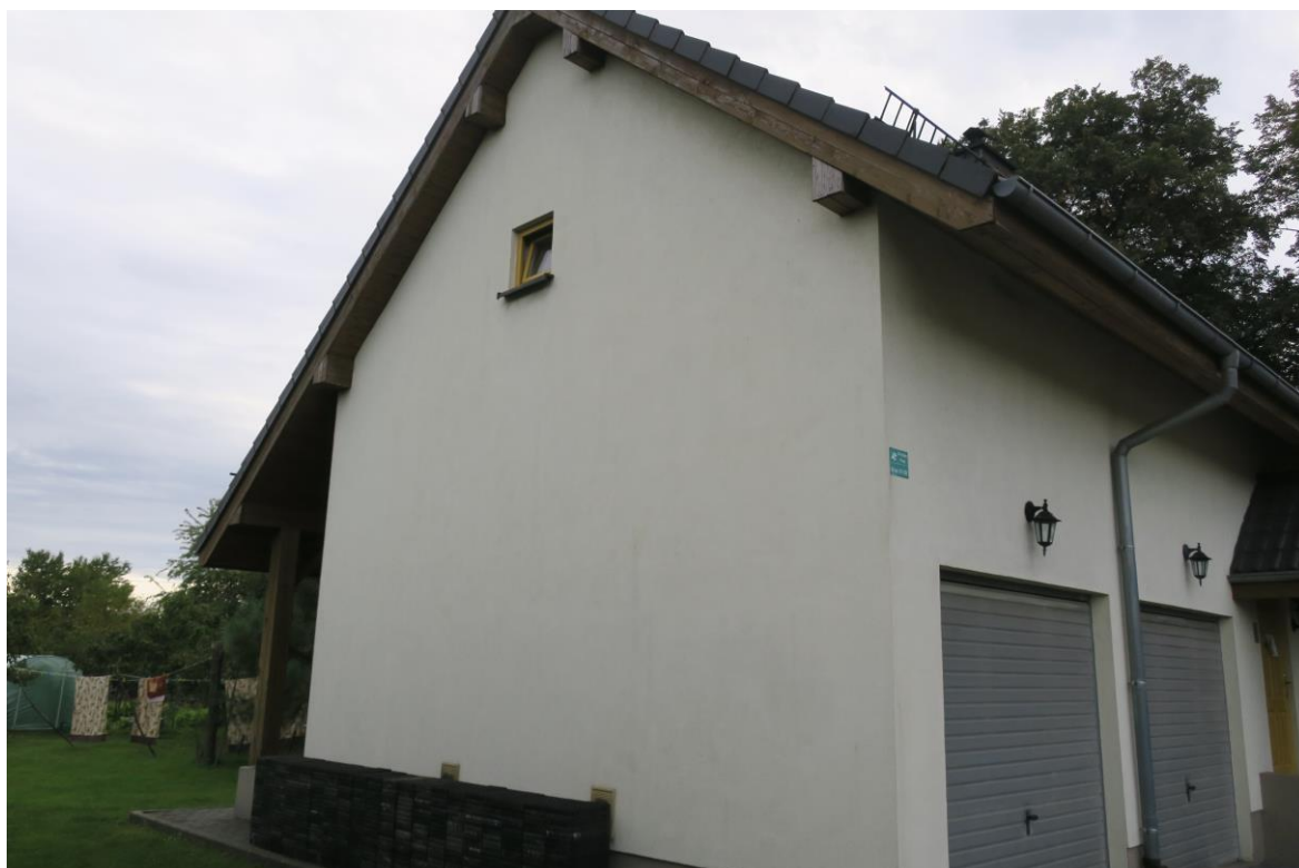
Fot. 2 – ściana szczytowa – podbitka i elewacja do malowania
