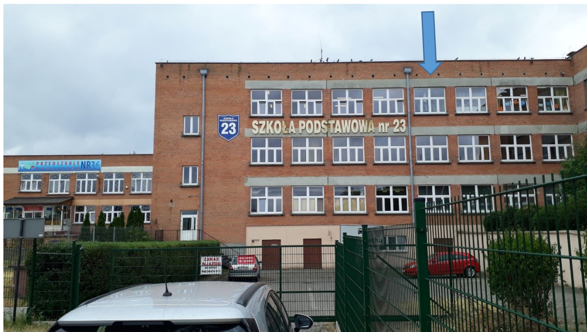
Rys. 4 Miejsce montażu SELMS PEM – Szkoła Podstawowa Nr 23 we Włocławku – widok z poziomu gruntu
