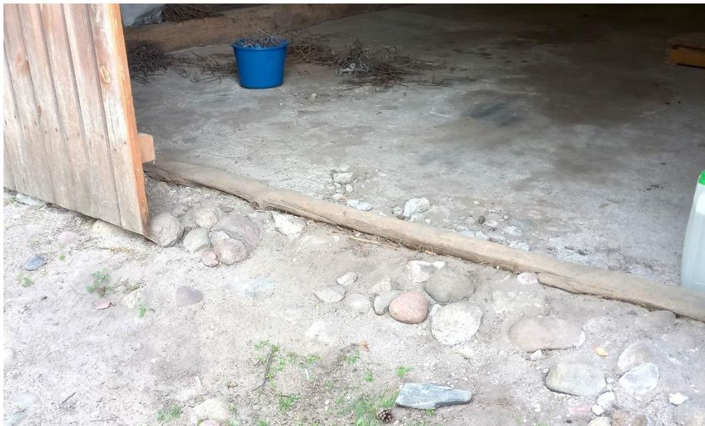
Fot. 10 Budynek stodoły – próg i posadzka
