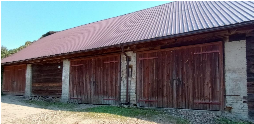
Fot. 4 Budynek stodoły – drzwi zewnętrzne
