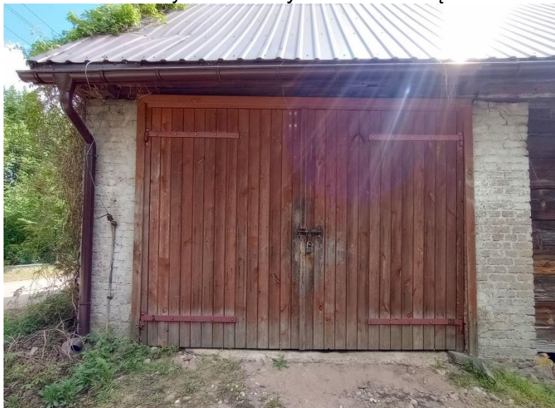
Fot. 5 Budynek stodoły – drzwi zewnętrzne 1
