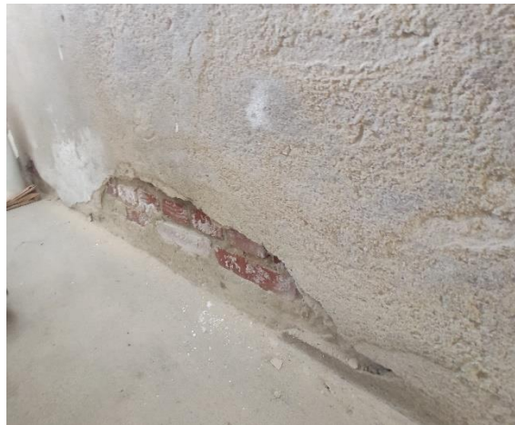
Fot. 2 Budynek gospodarczo - magazynowy – tynki wewnętrzne
