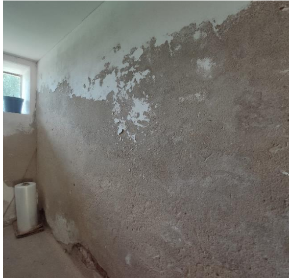
Fot. 1 Budynek gospodarczo - magazynowy – tynki wewnętrzne
