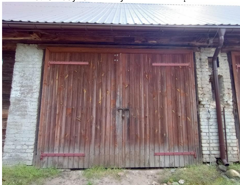
Fot. 6 Budynek stodoły – drzwi zewnętrzne 2
