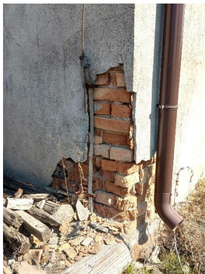
Fot. 3 Budynek gospodarczo - magazynowy – ściana zewnętrzna
