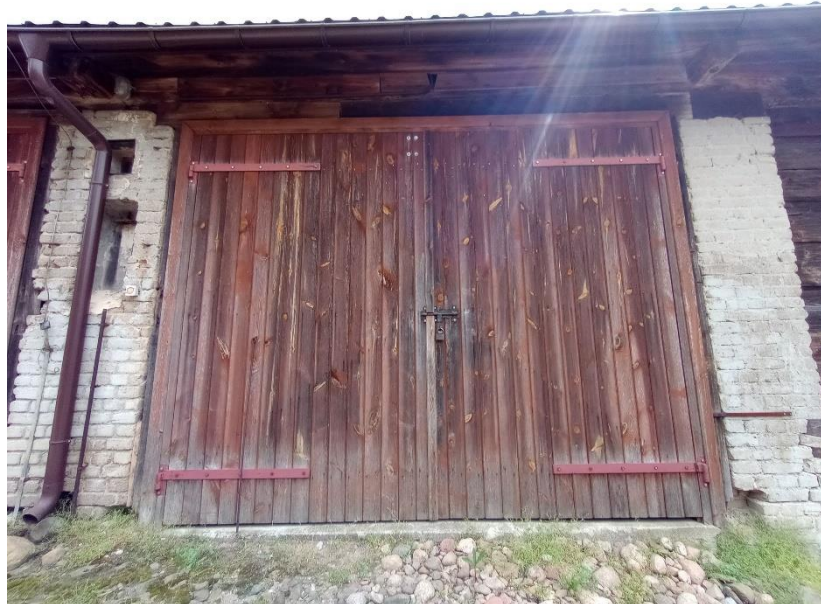
Fot. 7 Budynek stodoły – drzwi zewnętrzne 3
