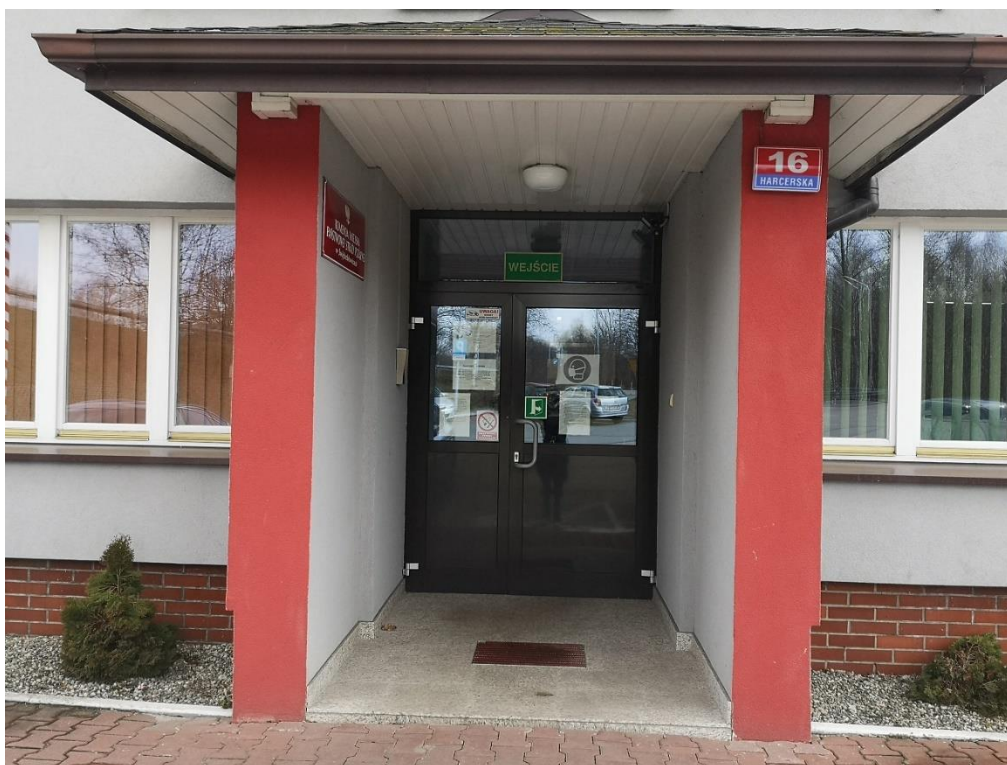
Zdjęcie nr 1 – Wejście główne do budynku.
